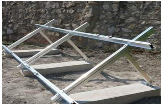
Imagen 7.7. Instalación de los soportes elegidos.
