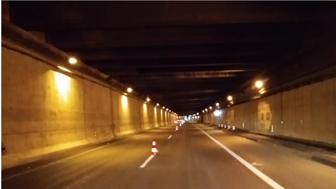
Imagen 3.12. Iluminación nocturna en el interior del túnel.
