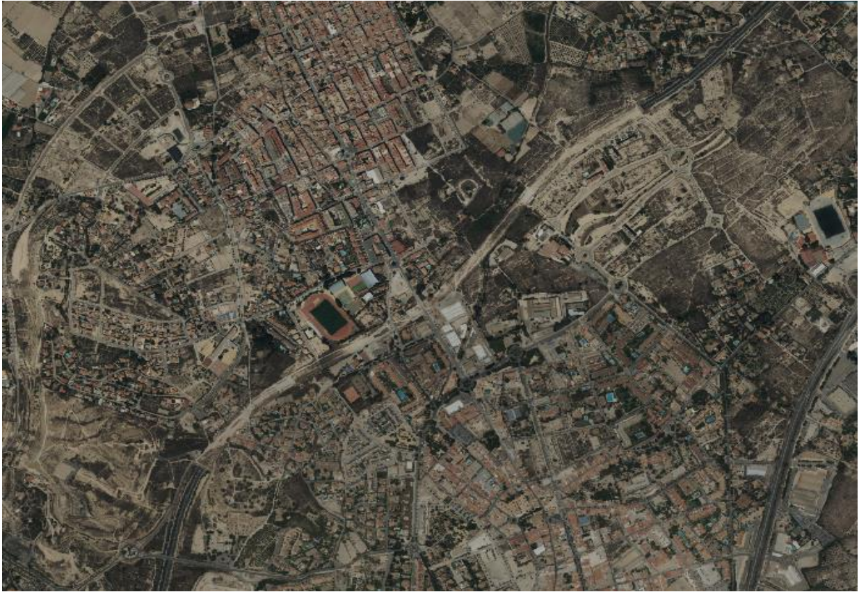
Imagen 1.2. Vista satélite del túnel.
