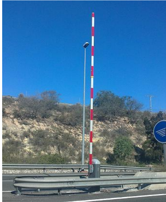
Imagen 2.4. Barrera boca Norte.
