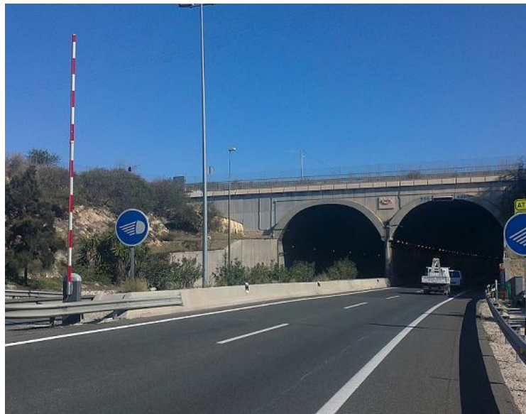
Imagen 1.4. Boca Norte del túnel de San Juan.
