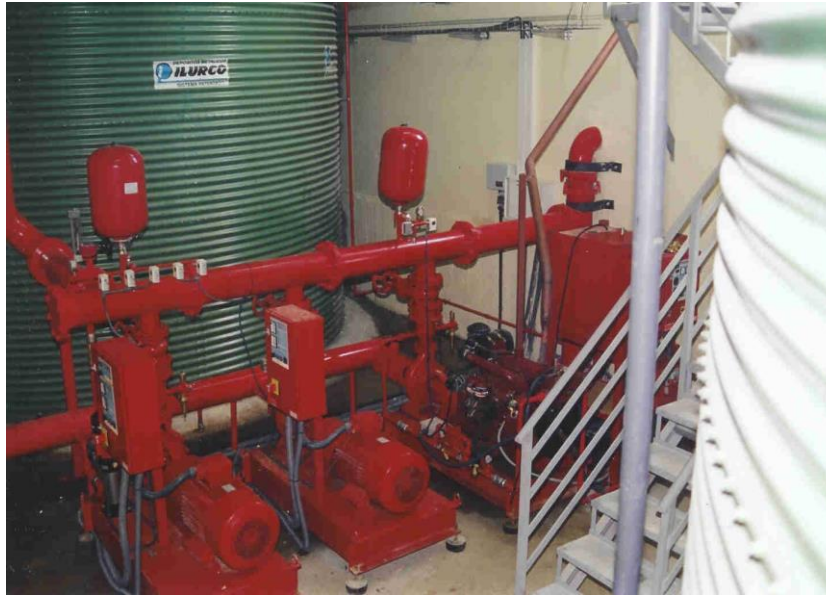
Imagen 2.2. Sistema de presión de emergencia.
