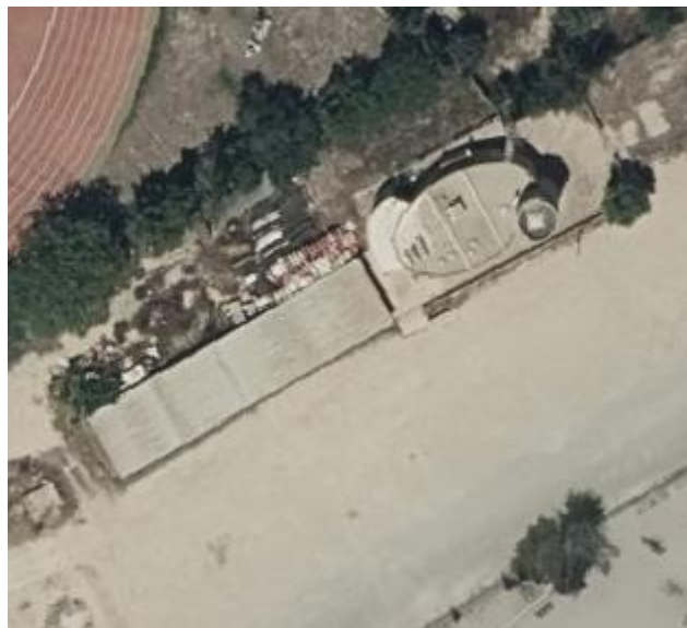
Imagen 1.8. Vista satélite del local técnico del túnel de San Juan.
