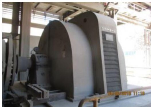
Fig. 9 Motor Rotor Bobinado en Industria
