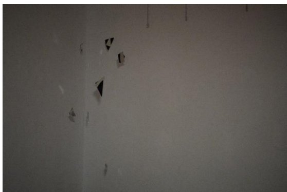
Fig, 98, Foto de la instalación de red , Inés Regaña, Bétera. 2018
