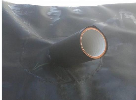
*Figura 44 – Impermeabilización de la tubería forzada en la cámara de carga (Imagen tomada de la página web de “Fugisa geosintéticos”)*
