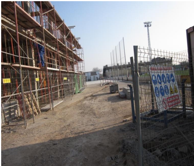
COMIENZO EN OBRA: Vista longitudinal de la obra. El solar está entre la pared anterior del polideportivo y el campo de fútbol local.
