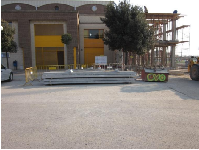
COMIENZO EN OBRA: En esta imagen se ve el momento de incorporarme a la obra el día 10-02-2011. Y se adivina la estructura que pretende continuar arquitectónicamente el polideportivo.
