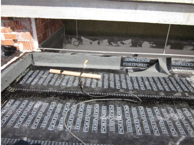
DESCRIPCIÓN: El instalador de cubiertas reposa el soplete por encima de la propia lámina sensible al calor y sobre un tubo de cartón inflamable.
