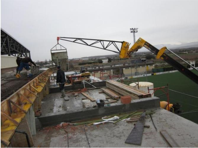
DESCRIPCIÓN: Hormigonan subiendo el material con una carretilla elevadora de brazo telescópico. El material entra lateralmente al tajo y la persona que lo maneja no tiene contacto visual del plano de arriba.
