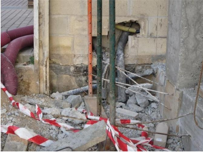
**DESCRIPCIÓN:** La acometida eléctrica del campo de futbol cercano discurre por debajo de una parte de nuestra obra. Sus tubos expuestos y rotos dejan ver parte de los conductores. Las esperas están desprotegidas y el suelo está lleno de cascotes y maderos con clavos.
