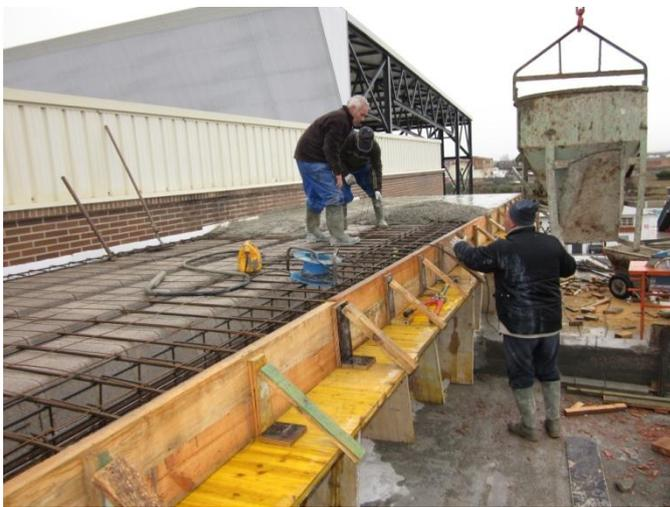
DESCRIPCIÓN: Con las prisas colocan el vibrador sobre una bovedilla que parte, cae al piso inferior y debe ser repuesta.
