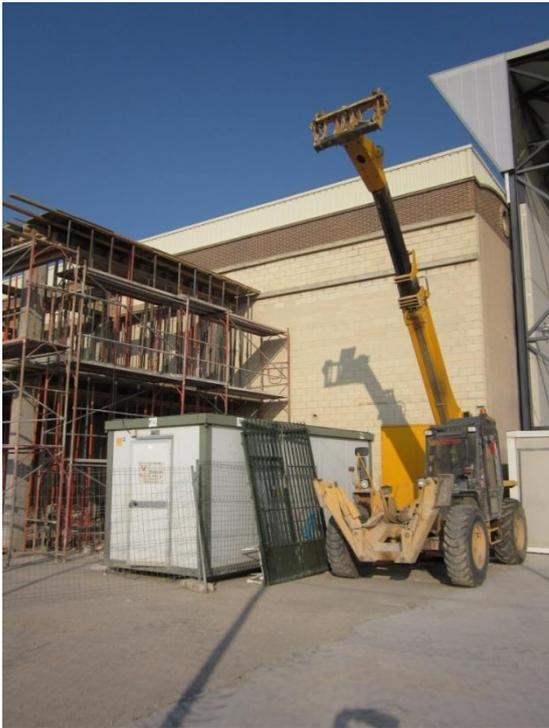
DESCRIPCIÓN: En el plan del proyecto de ejecución, y en el estudio básico de seguridad y salud se propone una grúa para mover el material en obra y una determinada organización del espacio de la obra. Esta disposición no se sigue. Los acopios se llevan fuera de la obra, no se coloca la grúa y en su lugar se mueven los materiales con esta carretilla de brazo telescópico.
