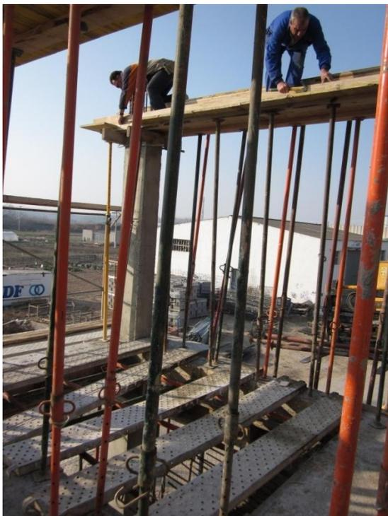
DESCRIPCIÓN: Dos operarios trabajan en altura de manera temeraria sin medidas de protección ni colectivas ni personales. Además el hueco de abajo está deficientemente tapado con chapas que pueden invitar a una falsa idea de seguridad.
