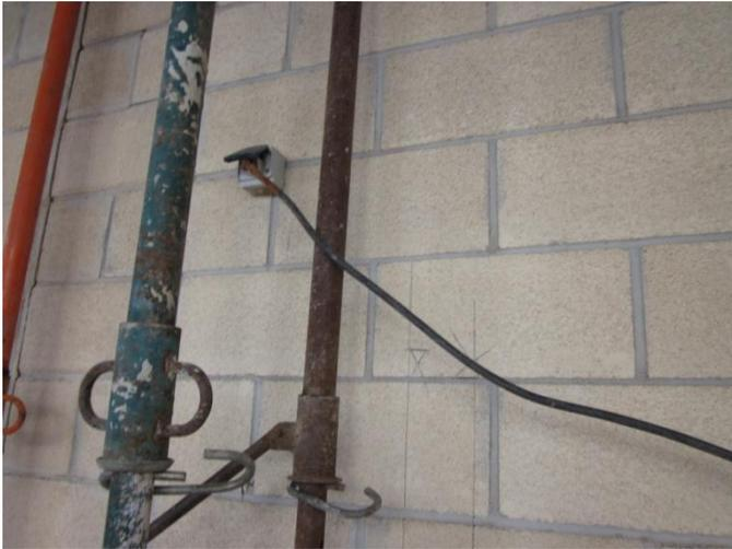
**DESCRIPCIÓN:** La toma de corriente que les provee para las herramientas no proviene de un cuadro de obra, con lo cual está infradimensionada para su uso. Aparte el cable conductor presenta un empalme defectuoso y potencialmente peligroso como es un empalme protegido con cinta adhesiva aislante.
