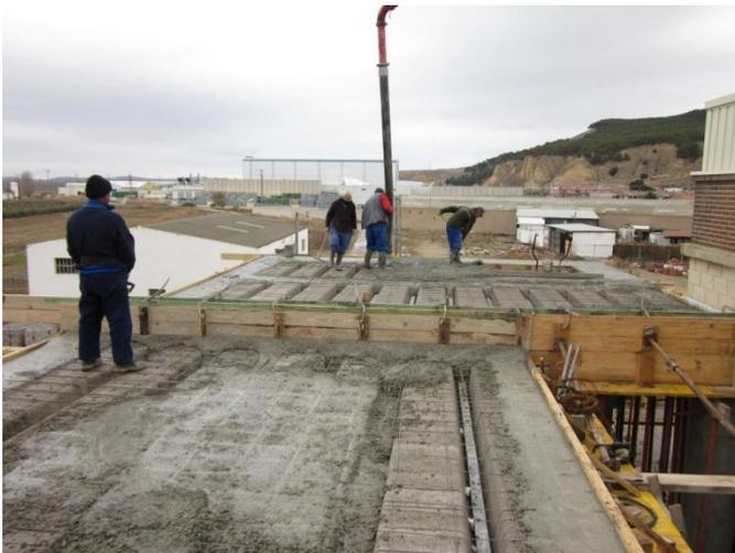
**DESCRIPCIÓN:** Mientras efectúan el bombeado del hormigón no prestan atención a la sacudidas de la trompa de hormigonado y eso que no están las medidas colectivas de protección ante el riesgo de caídas.
