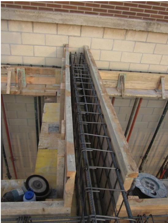
**DESCRIPCIÓN:** El encofrado de una viga con un vano adyacente tiene riesgo de caída a gran altura y no hay protecciones colectivas como redes, barandillas o mejor tableros que eliminen el riesgo. Además en el poco paso que dejan (20 cm) aprovechan para dejar los útiles de trabajo.
