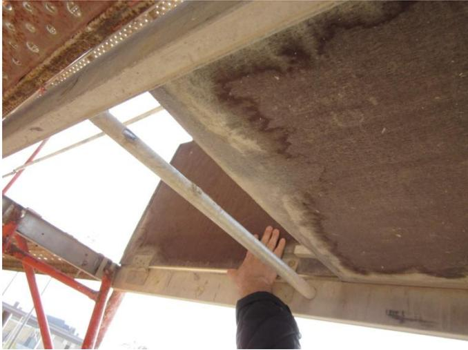
DESCRIPCIÓN: En este caso ensalzo el detalle del sistema de trampilla del andamio porque tiene la virtud de permitir el acceso al nivel superior de obra con seguridad e incluso transitar por encima de este sin riesgo de caída.
