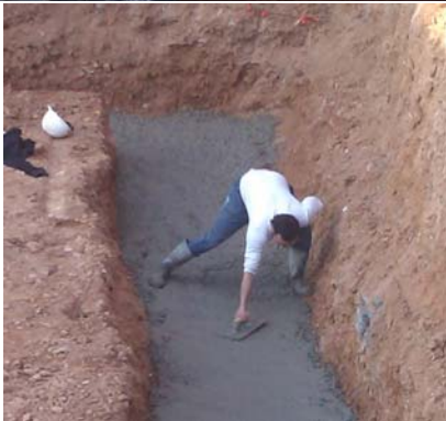
(Foto 2). Aplanamiento del hormigón de limpieza.
