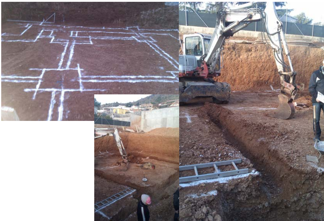
(Foto 1). Comprobación del replanteo de la cimentación.
