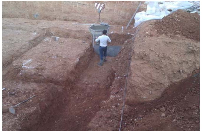
(Foto 1). Vertido de hormigón de limpieza.
