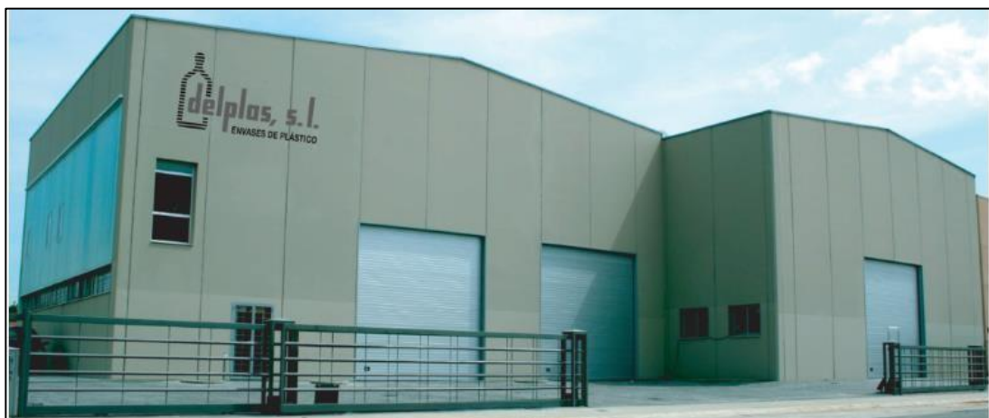
Figura 3. Nave industrial Delpas SL
