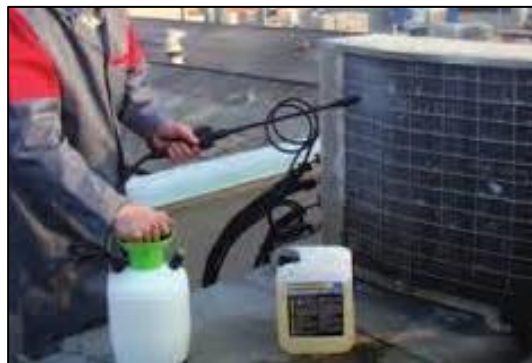
Figura 72. Técnico limpiando el filtro del condensador
