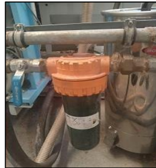
Figura 46. Limpieza de filtros.
