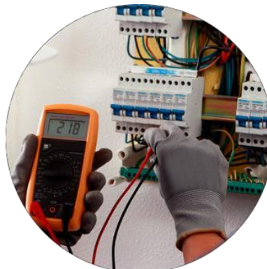
Figura 38. Medición de corriente eléctrica.
