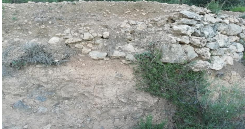
Ilustración 2 Banca destruido a causa del abandono. Fuente: Elaboración propia.
