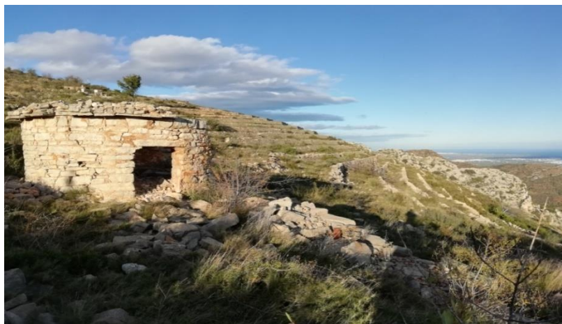
Ilustración 3 Torre de vigilancia en el interior de la parcela. Fuente: Elaboración propia.
