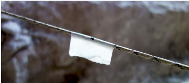
Figura 10. Puntos de referencia nivelados para registrar las irregularidades o alturas en suelo y techo. Fuente: S. Manzano.
