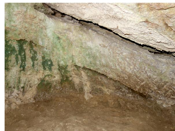
Figura 91. Grietas de gran longitud y profundidad en el techo abovedado de la tumba nº 11. Fuente: S. Manzano.
