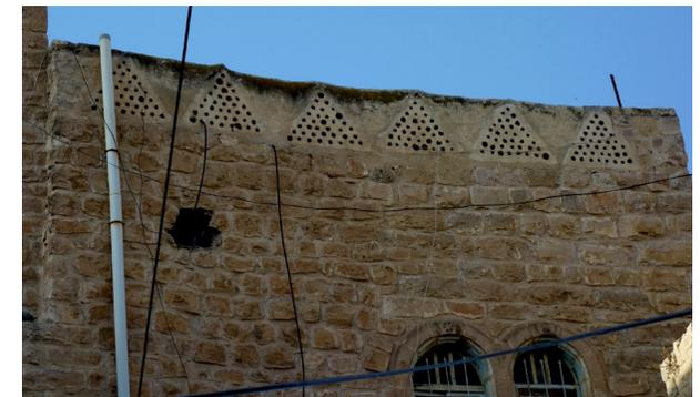
Figura 25. Ventilación de cubierta en Hebrón. Fuente: S. Manzano.
