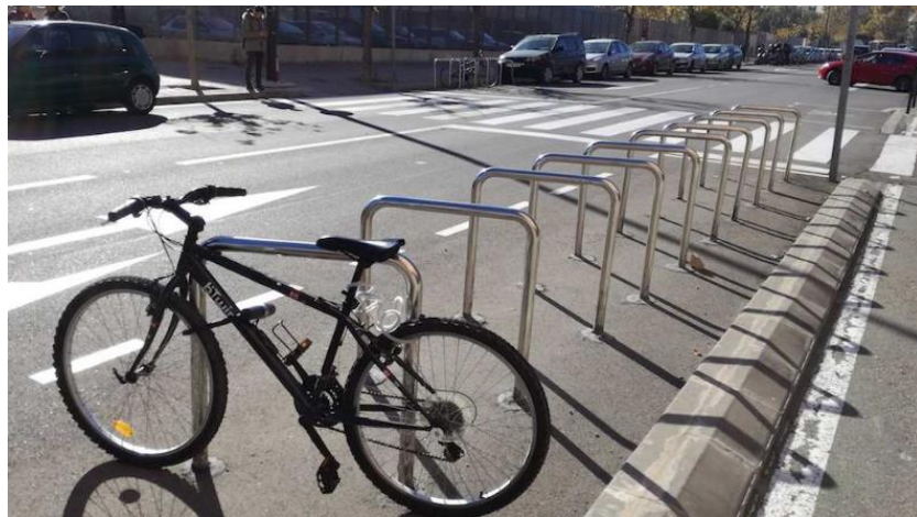
Figura 127. Diseño de estacionamiento de bicicleta en U invertida
