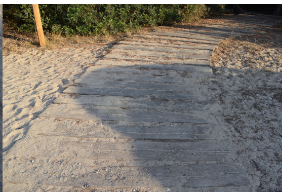
Imatge 24. Baldes de fusta de l'accés d'entrada.
