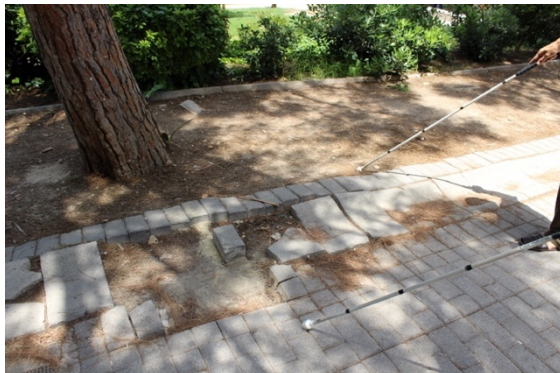
Imatge 11. Paviment defectuós per alçament d'arrels.
