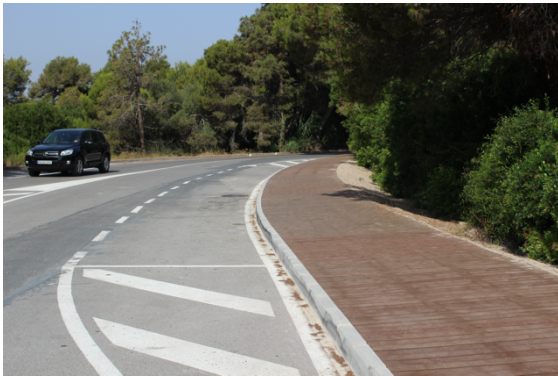
Imatge 21. Zona aparcament cimentada.
