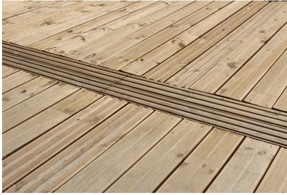
Imatge 34. Baldes de fusta de paviment tàctil i baldes de fusta del recorregut.
