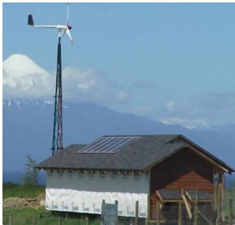
Figura 2. Ejemplo de un mini-aerogenerador para el autoconsumo en una vivienda aislada de la red. [2]
