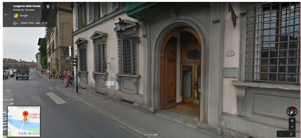
Fig. 22. Mi portal visto en Google Earth, (2018).
