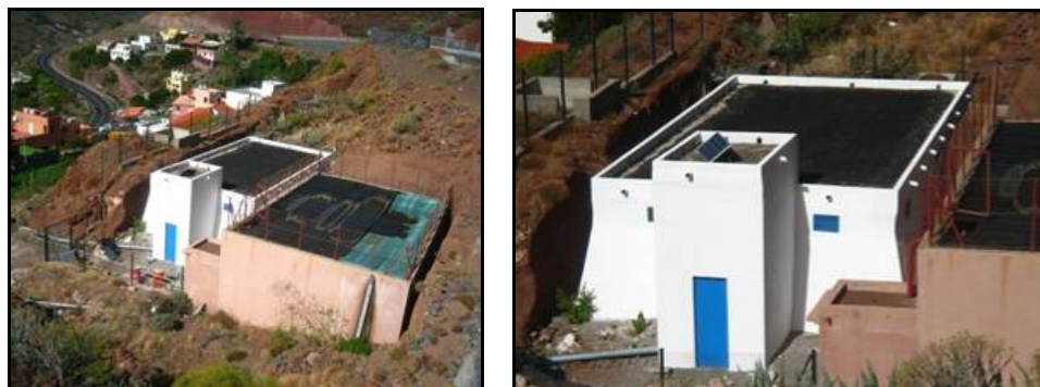
Figura 2.4: Imágenes del depósito del Molinito.
