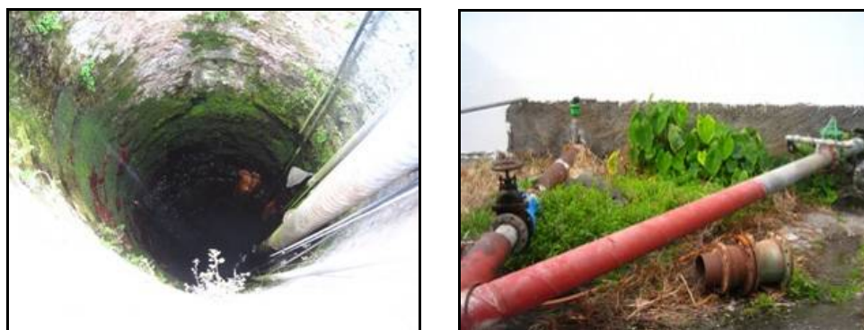
Figura 2.1: Imágenes del pozo de Raspaderos y conducciones de salida.
