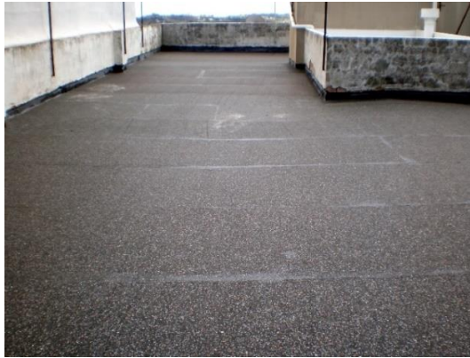
Figura 5. Cubierta plana, recrecida, con impermeabilización vista protegida.
