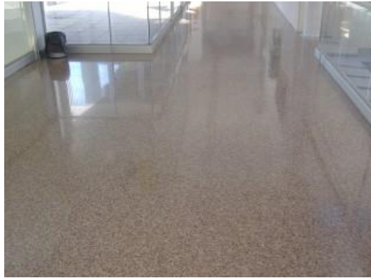
Figura 6. Terrazo sobre mortero, 50mm de espesor.
