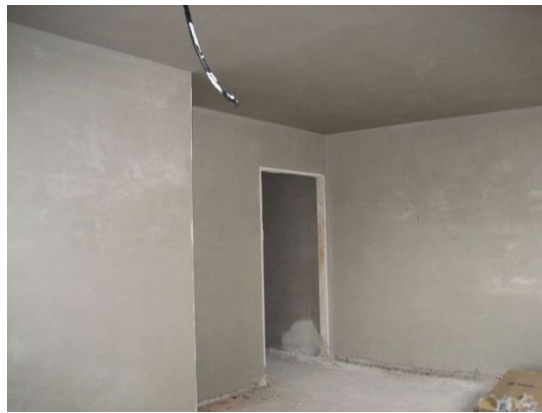
Figura 8. Guarnecido y enlucido de yeso.
