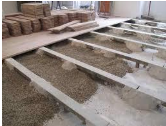
IMAGEN 6. Parqué y tarima de 20 mm de espesor sobre rastreles. Fuente: https://pavidisseny.com
