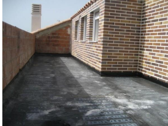
IMAGEN 8. Cubierta sobre forjado: cubierta plana, recrocido, con impermeabilización vista protegida. Fuente: https://enriquealario.com
