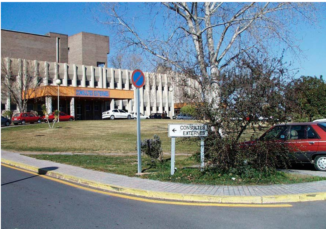
Figura 28: Fachada Este del edificio.
