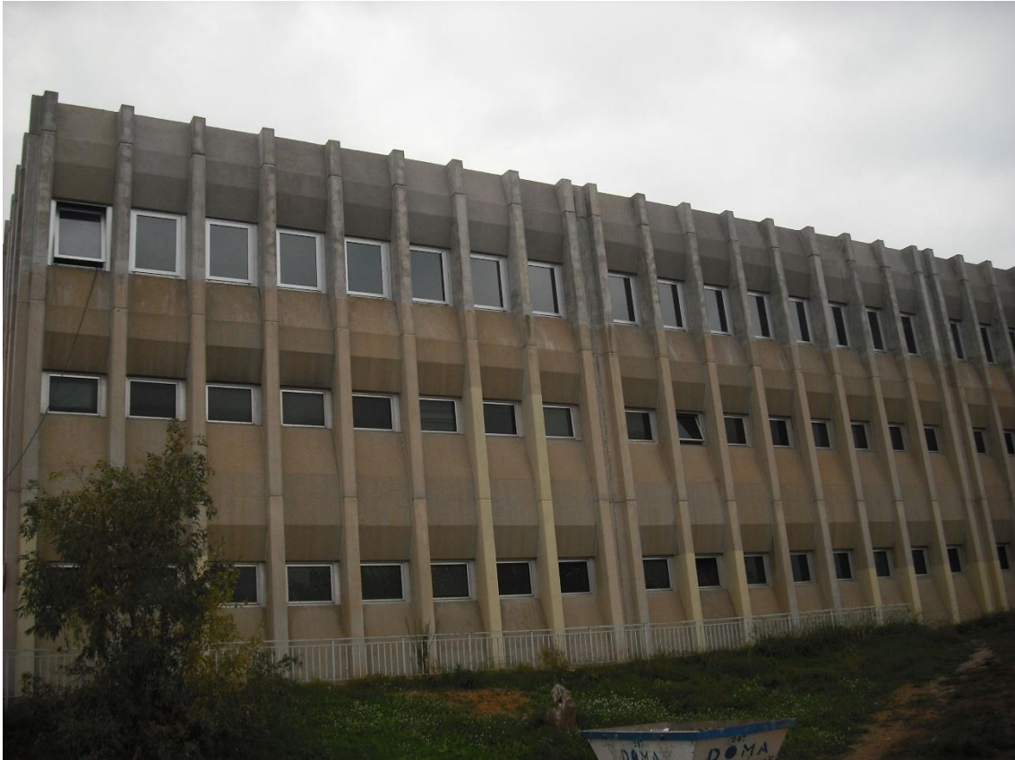
Figura 29: Fachada sur del edificio. Muros exteriores.
