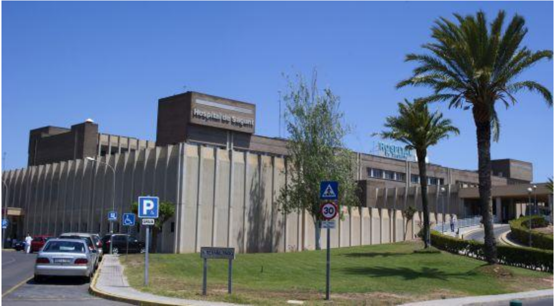
Figura 31: Muros de fachada de la zona suroeste del edificio.
