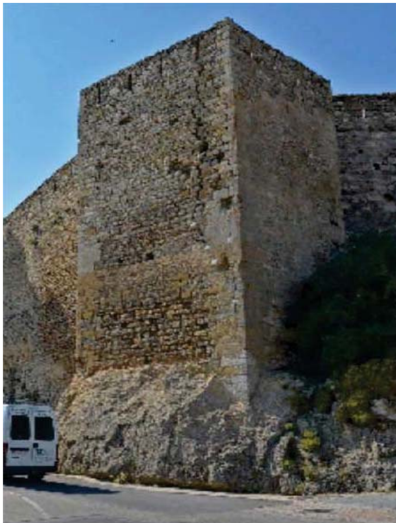
Imagen Torre del Racó previa al apeo estructural. Fuente: Vicente Dualde
