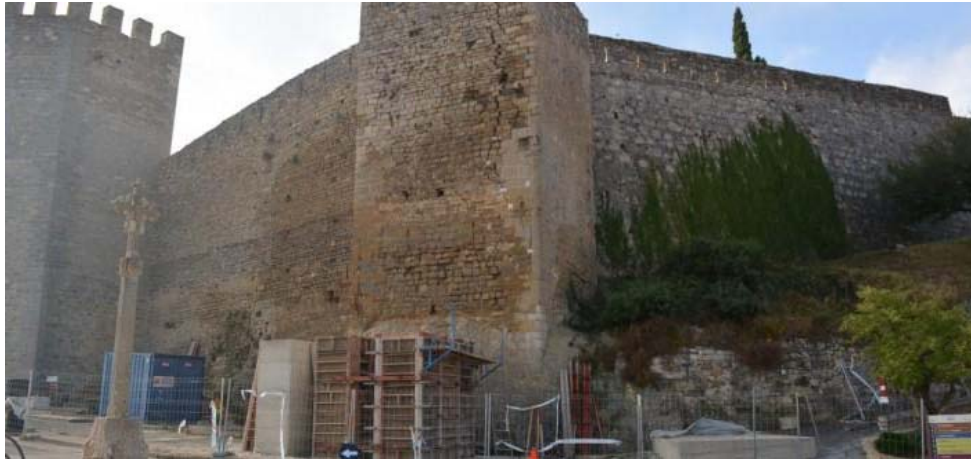
Imagen construcción dados hormigón estabilizador. Fuente: artículo CS-Información, 3/10/2016
