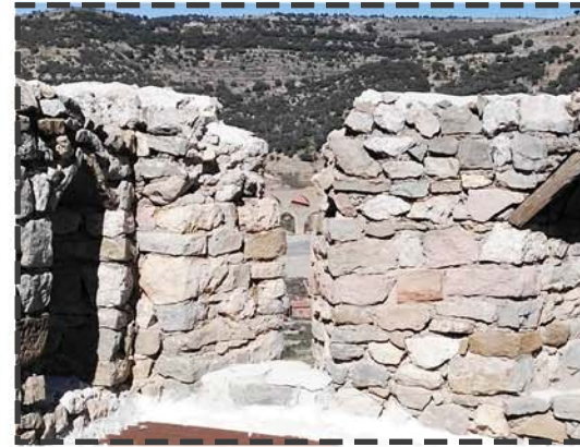
1. Desmante mampostería fisurada
