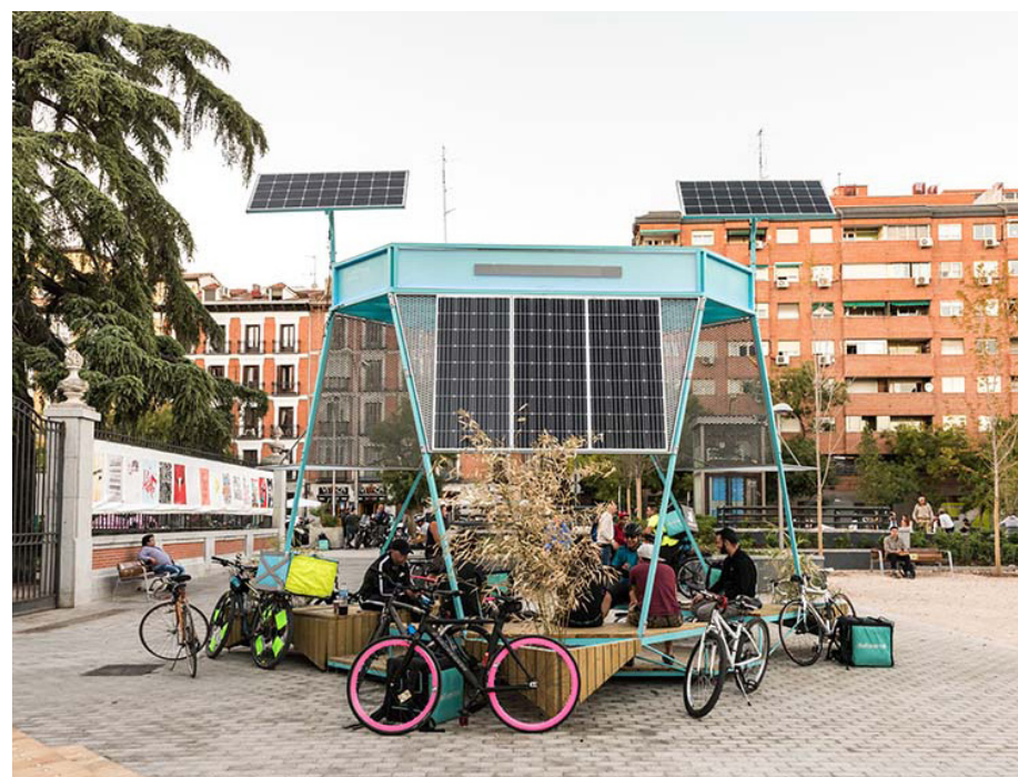
Imagen 24 - Infopoint acumulador de energía que proporciona un espacio de reunión al tiempo que obtiene y acumula energía solar.
