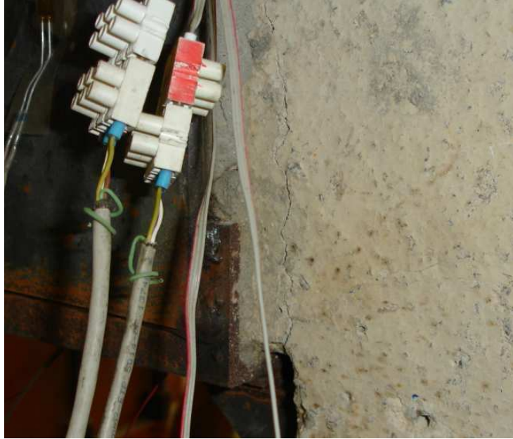
Fig. 3.38. Fisuración en la cara de tracción aparecida en el entronque del soporte con el nudo en las probetas RC-L3
