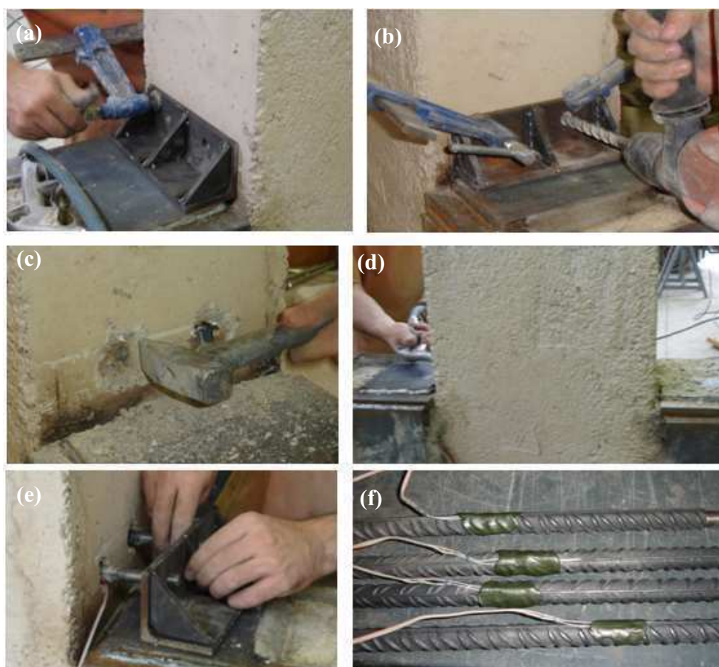
Fig. II.12. Instalación de los capiteles y barras pasantes (I). (a) Colocación del capitel y sujeción provisional; (b) Ejecución de taladros; (c) Picado manual para descubrir los tubos de PVC; (d) Limpieza de la conducción de PVC con aire comprimido; (e) Colocación del capitel con las barras pasantes; (f) Barras de acero corrugado instrumentadas empleadas como barras pasantes
