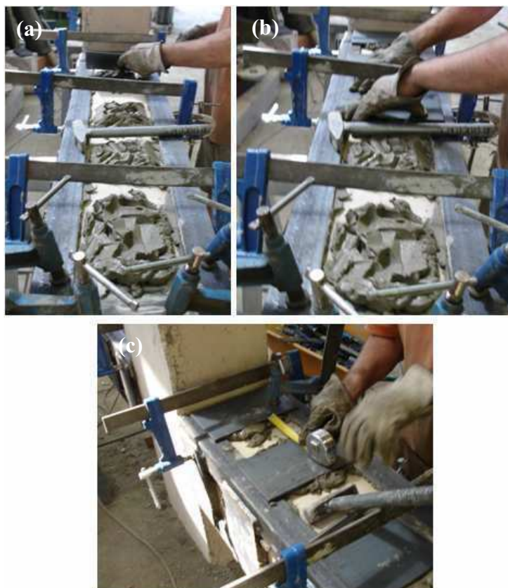
Fig. II.8. Montaje de las presillas metálicas. (a) Disposición de la capa de mortero previa a la colocación; (b) Posicionamiento de las presillas; (c) Ajustado y sujeción provisional
