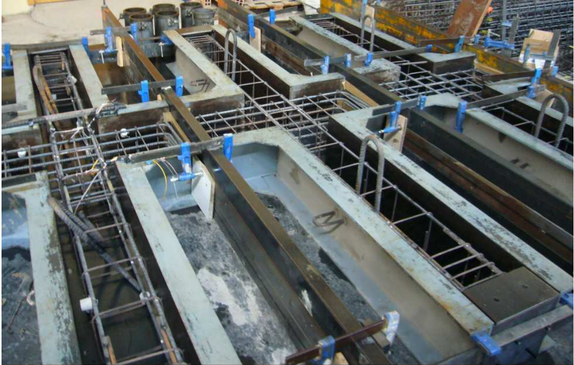
Fig. II.3. Probetas ferralladas dispuestas en los encofrados
