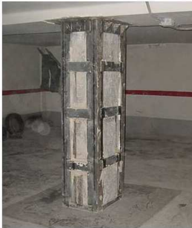
Fig. 2.4. Soporte reforzado con angulares y presillas metálicos
