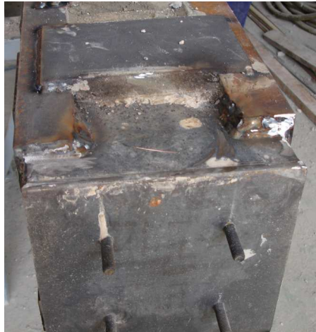
Fig. 3.12. Detalle de la soldadura de los angulares de refuerzo al cajón metálico del extremo de las probetas
