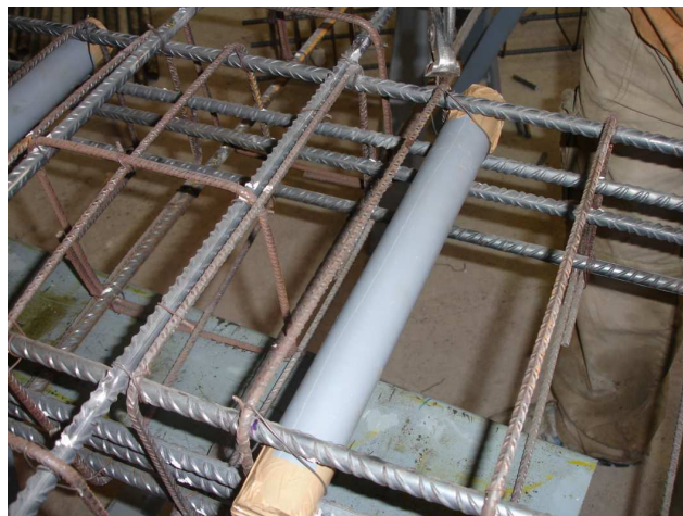
Fig. 3.14. Tubos de PVC embebidos en el hormigón para pasar posteriormente las barras de acero en las probetas tipo B
