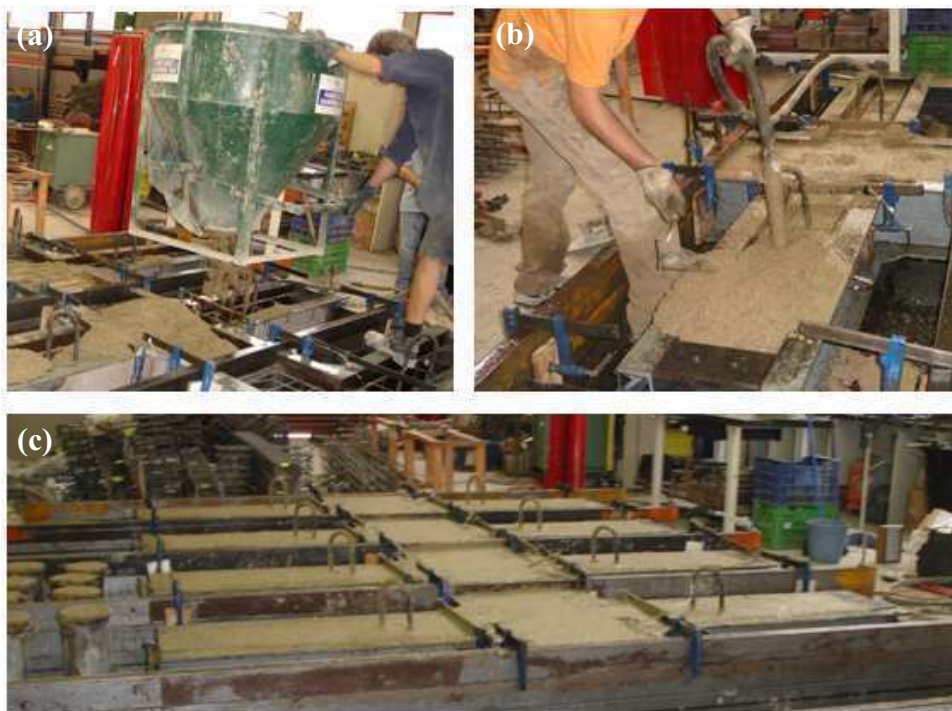
Fig. II.5. Proceso de hormigonado de las probetas. (a) Vertido con cubilote; (b) Vibrado; (c) Vista de las probetas hormigonadas
