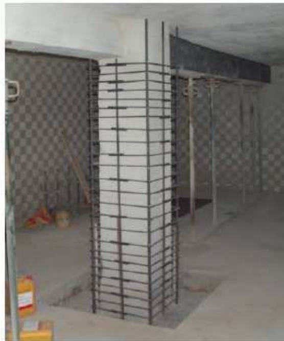
Fig. 2.1. Ferrallado de un soporte para su refuerzo mediante recrecido de hormigón
