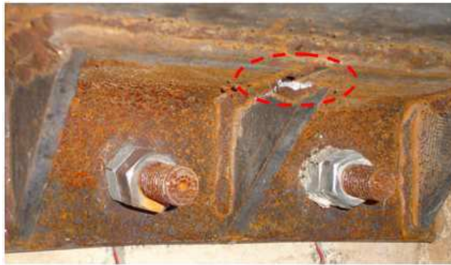
Fig. 3.25. Rotura de la soldadura del rigidizador central en los capiteles en tracción ocurrida en la probeta B-L1-1
