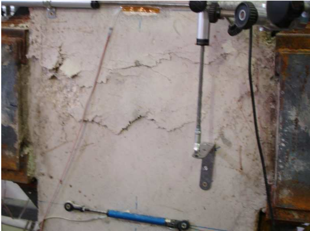
Fig. 3.34. Fisuración aparecida en la cara de compresión en las probetas RC-L2
