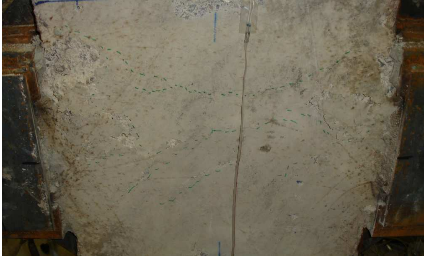
Fig. 3.51. Daños y fisuras en la zona comprimida del nudo en las probetas B-L2
