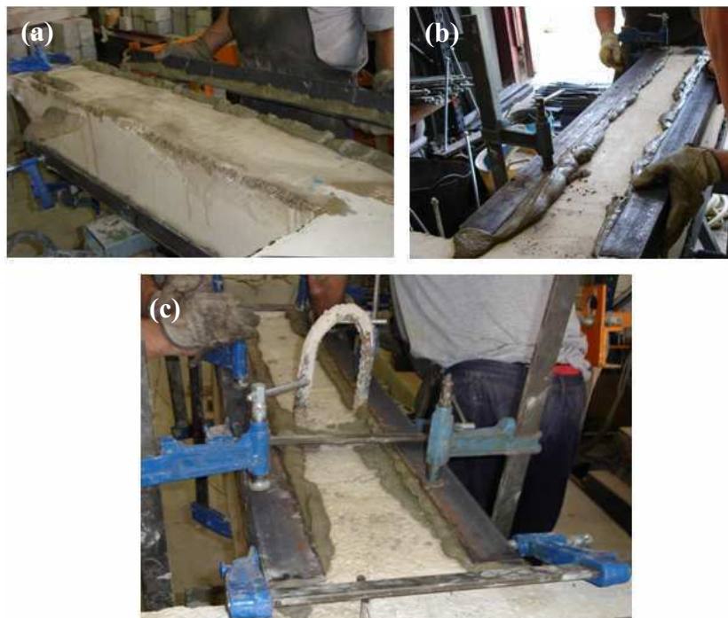
Fig. II.7. Montaje de los angulares de refuerzo. (a) Disposición de la capa de mortero; (b) Colocación de los angulares; (c) Fijación provisional mediante gatos
