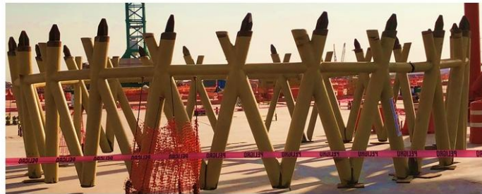
Fig. 7 Unión de los tres ensambles del tramo 1 según modelo y disposición de placas guía (Elaboración propia CTVM, 2018)
