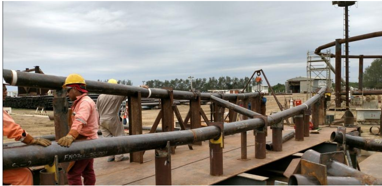
Fig. 6 Fabricación de ensambles a partir de las piezas cortadas en taller (CTVM, 2018)
