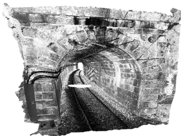
Figura 1: Modelo de nube de puntos sin tratar de un túnel del trazado en estudio. Fuente: Elaboración propia (2018).
