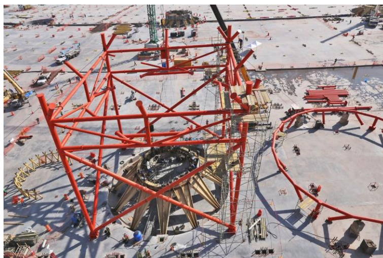
Fig. 8 Ensamblados en obra para ser montados (CTVM, 2018)
