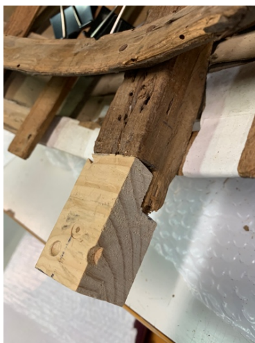
Imagen 32. Proceso de recomposición de la pérdida de madera.
