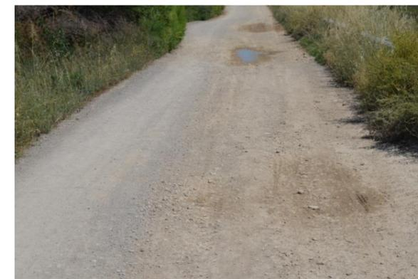
Ilustración 36: Detalle del estado del firme en tramo entre puente Bonrepòs-Carpesa y la pasarela peatonal. Fuente: Archivo propio.
