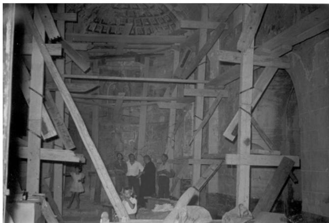
Fig.14. Vista de los andamios montados para proceder al arranque
