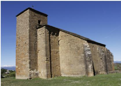
Fig.5. Vista exterior de la nave del S. XVI reforzada con contrafuertes y la torre
