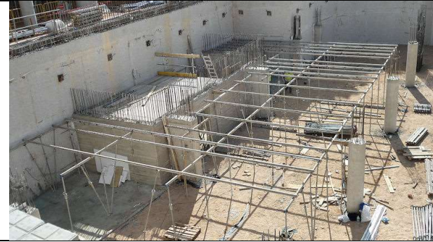
2 de mayo de 2012. Bloque1: Replanteo y determinación del nivel para encofrado del forjado 1º.
