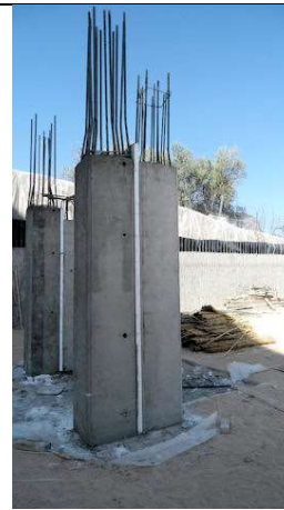
16 de marzo de 2012. Detalle de la junta estructural en sótano -1. Desenclavado de pilares y curado.
