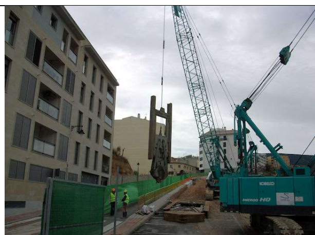
Lunes, 7 de noviembre de 2011. Fase inicial excavación de zanjas y ejecución de los muretes guía en B2 (Pabellón deportivo norte)
