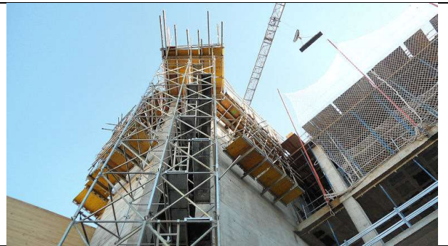
16 de noviembre de 2012. Bloque 1. Núcleo de hormigón. Oeste. Encofrado pantallas de hormigón en planta PAC.
