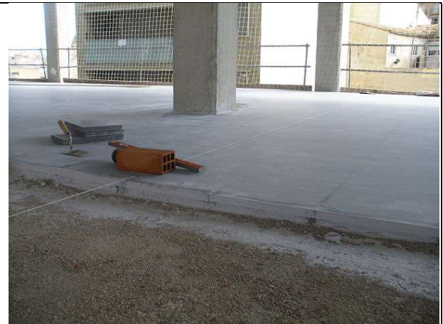
Comprobación de nivel del terrazo ejecutado en planta 1ª. Se han realizado las juntas de pavimento alrededor de pilares.
