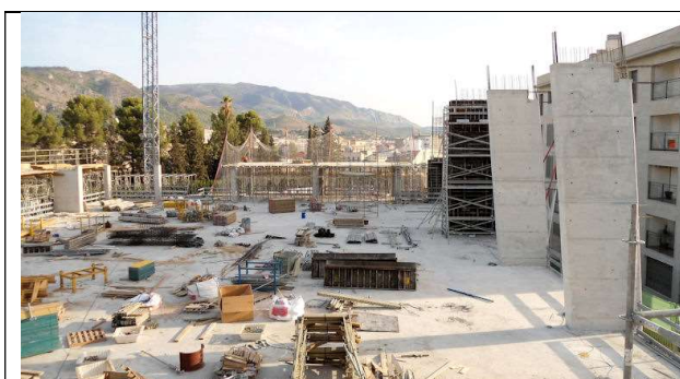
21 de agosto de 2012 Bloque 2: Vista de planta baja del pabellón donde arrancan los pilares que soportan las vigas de la estructura de madera.
