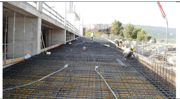
9 de agosto de 2012. Bloque 2: Hormigonado rampa -1 que asciende al pabellón. Previsible para circulación de personas y vehículos de mantenimiento.
