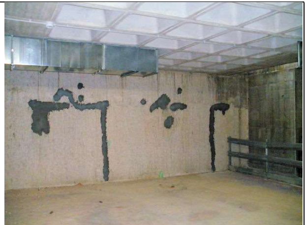
Tratamiento de las armaduras descubiertas durante el fresado y reparación del muro pantalla.
