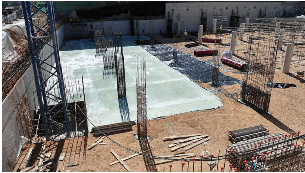
7 de mayo de 2012. Curado y protección del mortero con áridos de cuarzo y pigmentación natural coloreado VERDE.
