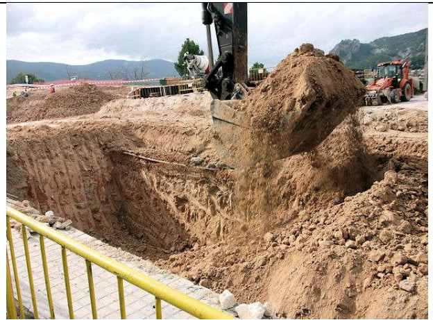
14 de noviembre de 2011. Excavación de zanjas previa a la ejecución del murete guía en la zona del pabellón polideportivo bloque 2.
