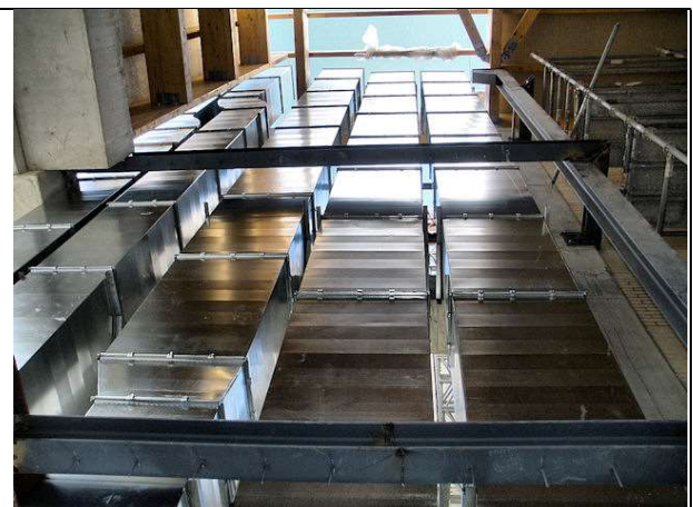
Estructura metálica de apoyo de los diferentes cerramientos de las chimeneas.
