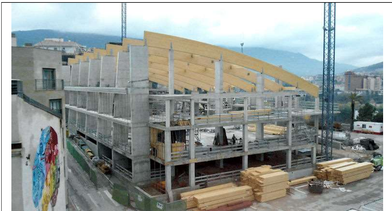
16 de noviembre de 2012. Vista general de la obra. En la estructura de madera de la cubierta del pabellón se atornillan las correas que arriostran los pórticos transversalmente.
