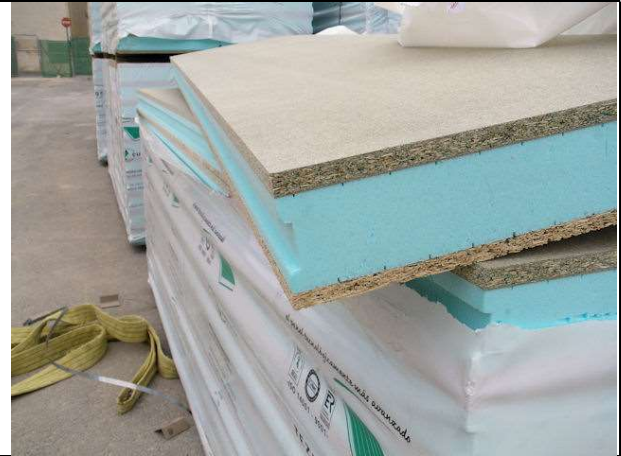
Recepción de panel sándwich para aislamiento de cubierta curva del pabellón polideportivo
