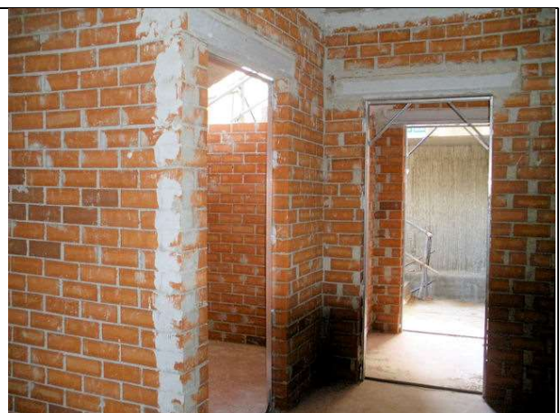
Ejecución de tabiquería, en sótanos, de ladrillo panal de 12 cm, colocación de premarcos de
