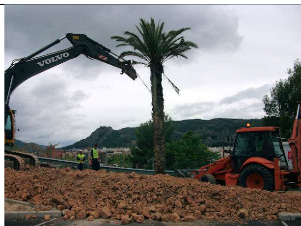
27 de octubre de 2011. Retirada de la palmera dentro del solar. 90% Demolición de pavimentos exteriores.
