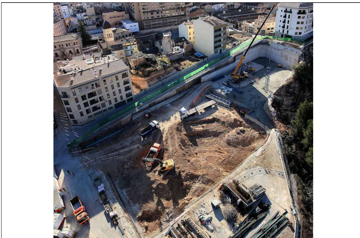
21 de febrero de 2012. Vista panorámica recogida desde zepelin en la que podemos apreciar la descarga del primer tramo para la grúa torre que se ubicará en el bloque 1 y cimentada en el sótano -1 de la planta de garaje. Los trabajos de vaciado del bloque 2 continúan ininterrumpidamente, mientras observamos como la mayor parte del hormigón de limpieza se ha extendido para replantear el armado de la losa 1.
