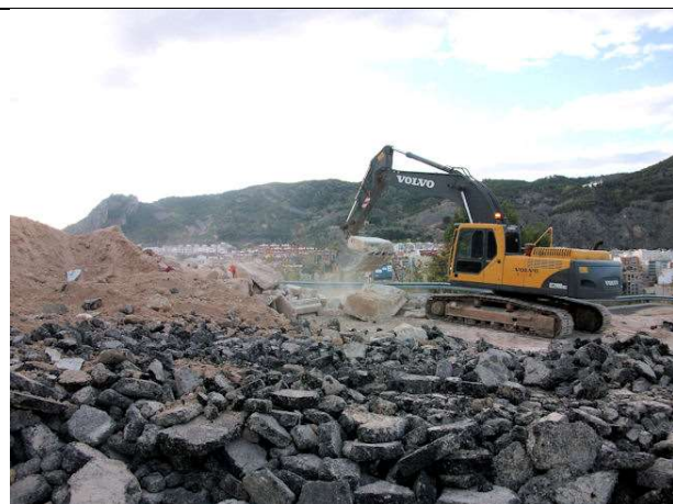
25 de octubre de 2011. Prosigue la demolición con retroexcavadora sobre cadenas con martillo rompedor.
