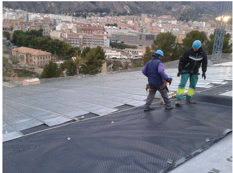
Ilustración 8. Fotografía durante la colocación de la chapa de zinc
