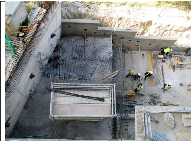
Armado muros de carga de hormigón de soporte de la escalera exterior 3
