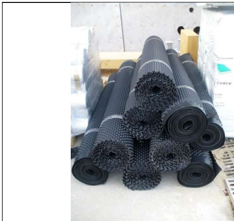
Recepción de lámina nodular de polietileno, para la capa de drenaje bajo la chapa de zinc.
