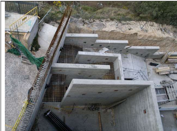
Armado tramo de escalera exterior 3. Comprobación de los conectores de la zanca y peldaños de hormigón.
