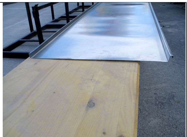
Engatillado simple de chapa de zinc para cubrir el faldón curvo a dos aguas de la cubierta del pabellón.
