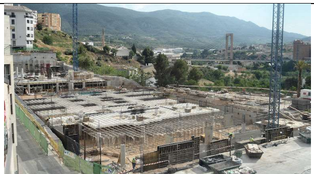
8 de junio de 2012. Mientras en el bloque 1 prosigue la ejecución de los pilares de planta baja en el bloque 2 se está encofrando el forjado 2º de la planta de garaje -1.
