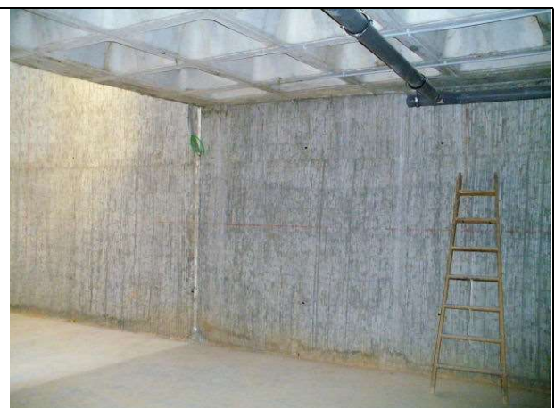
Prohibido el empleo de escalera de tijera en esta obra sin la autorización escrita del coordinador. Apercibimiento a los instaladores de Fulton.
