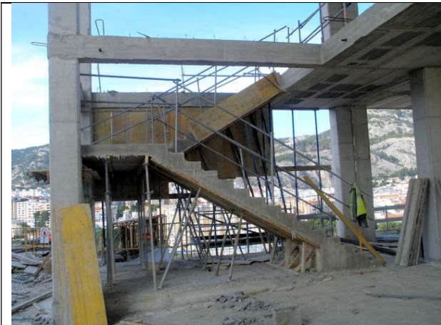
Desenfrado y curado del hormigón de escaleras interiores.
