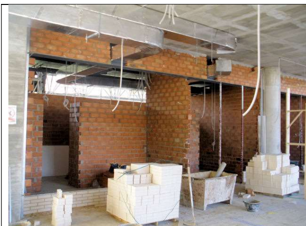
Una semana después de empezar tabiques interiores en vestuarios de gimnasio.
