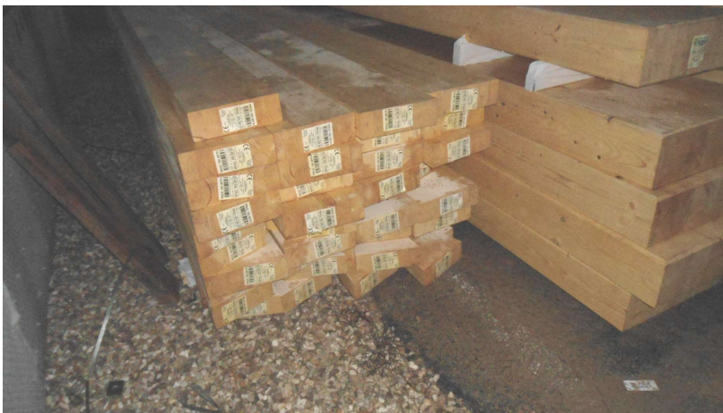
ACOPIO EN OBRA
