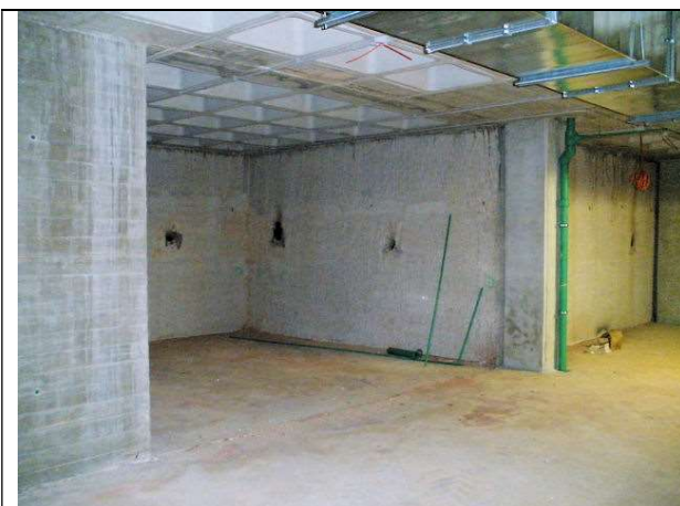
Colocación de tuberías para abastecimiento de agua potable. Retirada de las cabezas de anclajes provisionales y sellado de las perforaciones.
