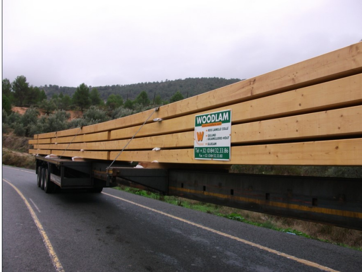
VIGAS PRINCIPALES (NO ENTRAN A OBRA DESDE C/ALICANTE CON GRUA DE 400TN SE IZAN Y SE COLOCAN)
