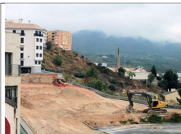
28 de octubre de 2011. Nivelación y formación de las plataformas de trabajo. para excavación del murete guía.
