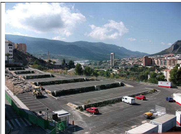
14 de octubre de 2011. Comienzo de demolición de pavimento asfáltico sobre base de hormigón.
