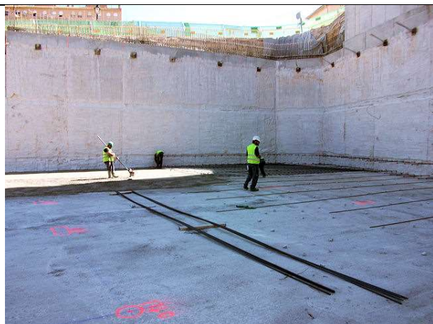
22 de febrero de 2012. Losa 1. Continúa extendiéndose el hormigón de limpieza. Replanteo de pilares.
