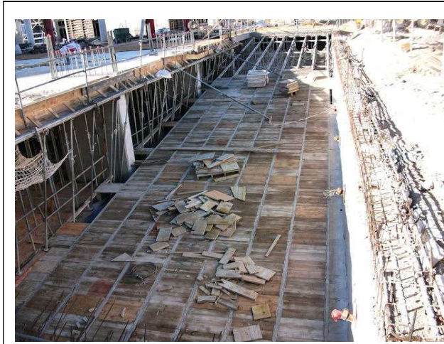
22 de junio de 2012. Bloque 2, Garaje -2: Encofrado de la rampa -2 que asciende al garaje -1
