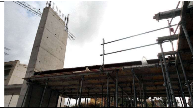
19 de septiembre de 2012. Bloque 2: Base de encofrado para losas y zunchos de atado alrededor del pabellón
