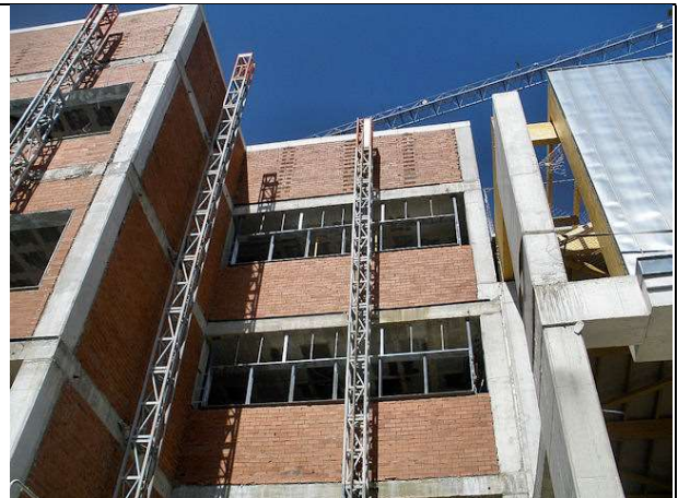
Concluye ejecución de hoja exterior de fachada ESTE.
