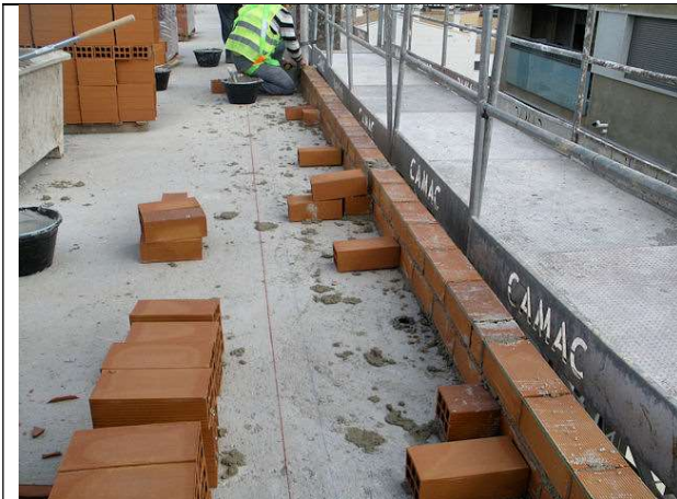
Antepecho de la cubierta del edificio nuevo de ladrillo hueco colocado a saga de ½ pié
