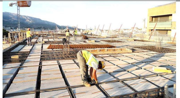
4 de octubre de 2012. Bloque 1: Armado del forjado 6º, Planta 3ª despachos y laboratorios.
