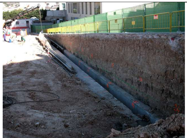
16 de noviembre de 2011. Continuidad de apertura de zanjas, encofrado y hormigonado de muretes guía en bloque 2.
