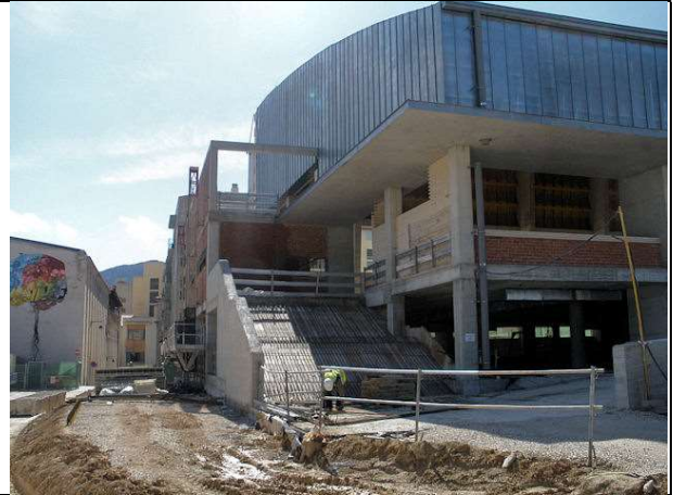
Armado de la escalera exterior 1 que da acceso al pabellón polideportivo por la fachada NORTE.
