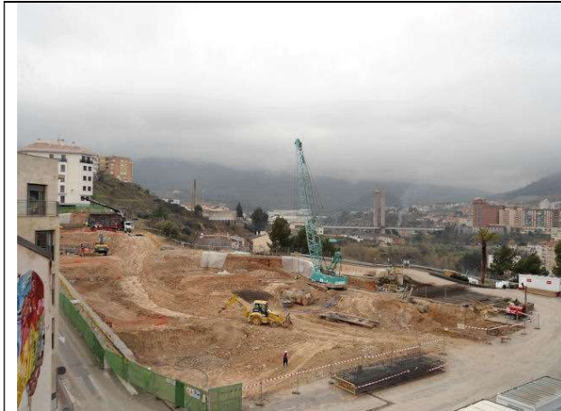
28 de diciembre de 2011. Limpieza del solar y ejecución de las pantallas de la fachada oeste.
