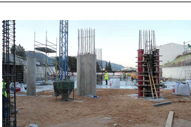
12 de marzo de 2012. Bloque 1: Primeros pilares desencofrados del edificio. Protección del fratasado de la losa 1.
