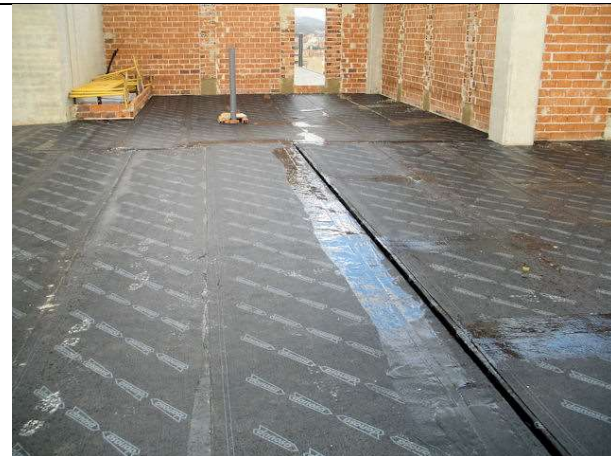
BLOQUE 1: Inicio colocación lámina asfáltica en las cubiertas invertidas.
