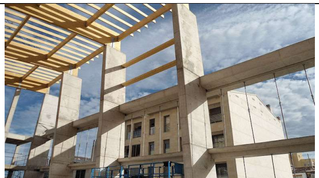
26 de noviembre de 2012. Bloque 2. Disposición de las correas de la fachada ESTE
