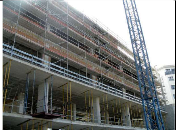
Montaje del andamio de fachada sobre mirador de planta 2ª. Ejecución hoja exterior de la fachada
