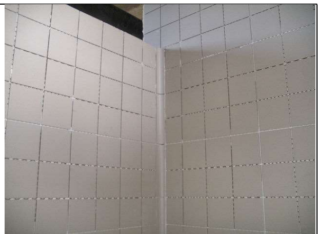
Impermeabilización con mortero hidrófugo. Alicatado de los vestuarios de planta baja.
