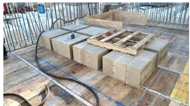
8 de mayo de 2012. Bloque 1. Núcleo de escalera y ascensores. Detalle del forjado reticular 1º de bloques de hormigón.
