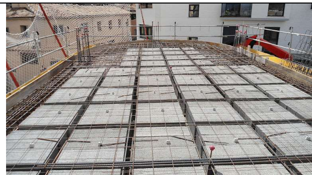
26 de septiembre de 2012. Bloque 1; Planta 3ª: Ejecución del forjado 6º
