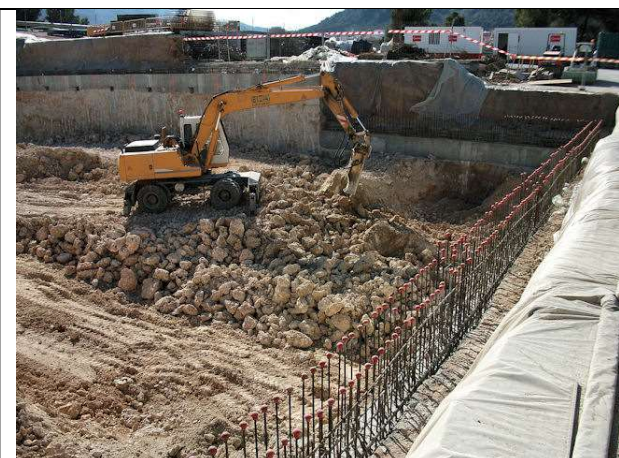
6 de marzo de 2012. Bloque 2 (pabellón): Demolición del sustrato de roca blanda, (origen calizo) en la esquina noreste.
