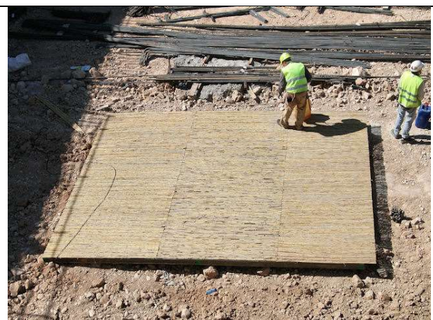
7 de marzo de 2012. Bloque 1: Preparación y colocación del encofrado del muro visto de cañizo de la esquina suroeste
