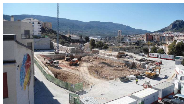
23 de febrero de 2012. La grúa torre se ha montado y se ha realizado la inspección y puesta en servicio
