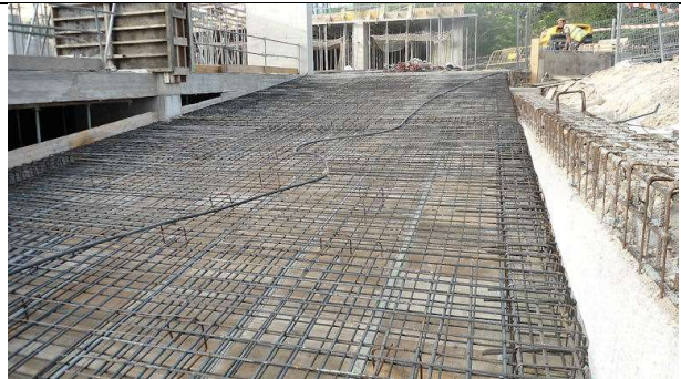
28 de junio de 2012. Bloque 2: Hormigonado de la Rampa -2. Detalle del encuentro con el forjado 2º
