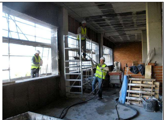
Proyección de mortero hidrófugo en intradós de la fachada oeste, previo a la colocación del aislamiento de lana de roca.
