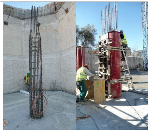
Lunes, 5 de marzo de 2012 Bloque 1: Armado y encofrado de pilares Forjado 3º caset/perd. Continua fratasado de la losa 1
