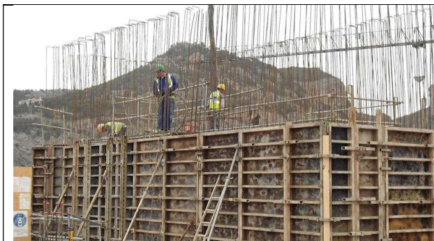
26 de noviembre de 2012. Bloque 1. Bombeo de hormigón pantallas del núcleo de escalera y ascensores. (Visto, tablero)
