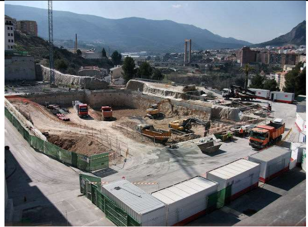
1 de marzo de 2013. Última fase de armado de la losa 1. El vaciado del bloque 2 se perfila para llegar al nivel de sótano -2
