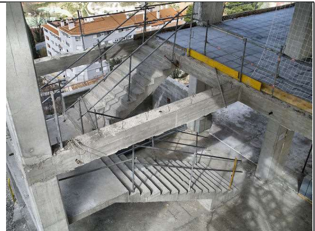
Desencofrado de escaleras interiores. Ejecución terrazos planta 2ª.
