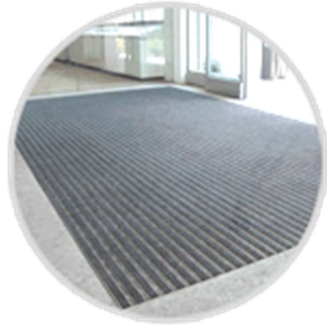
Ilustración 16. Bandas antideslizantes tipo moqueta para absorber el agua cuando entramos al edificio.
