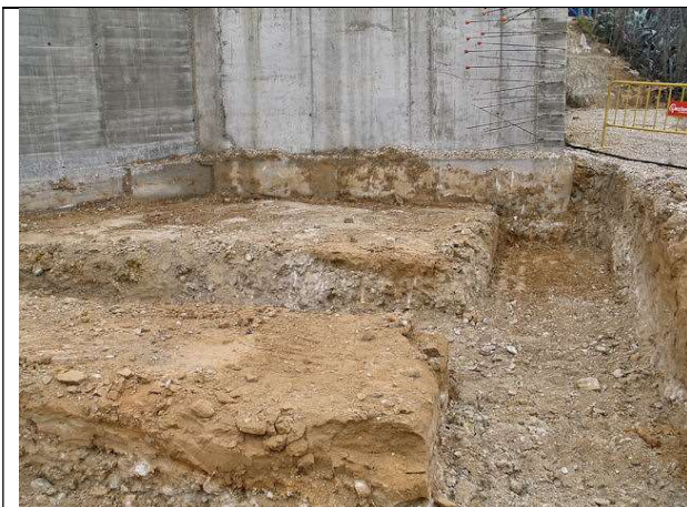
Comprobación del replanteo de zapatas corridas de cimentación de la escalera exterior 2
