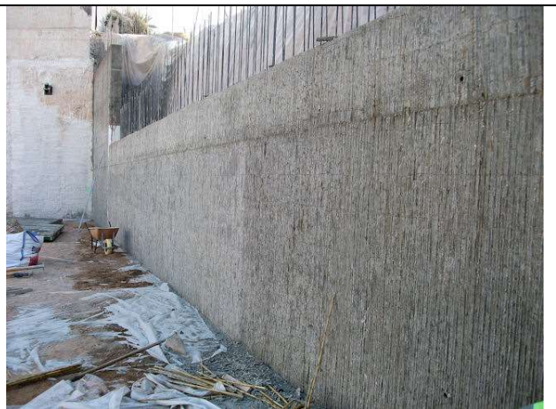
13 de marzo de 2012. Desencofrado del muro de sótano acabado cañizo
