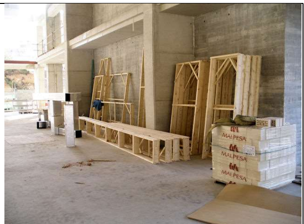
Recepción de premarcos de madera de la carpintería interior.
