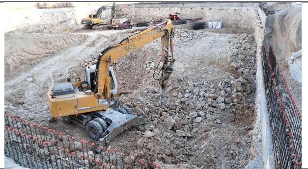
7 de marzo de 2012. Bloque 2: Apenas se ha llegado hasta el nivel de sótano -2 y continúa rompiéndose la capa de roca.
