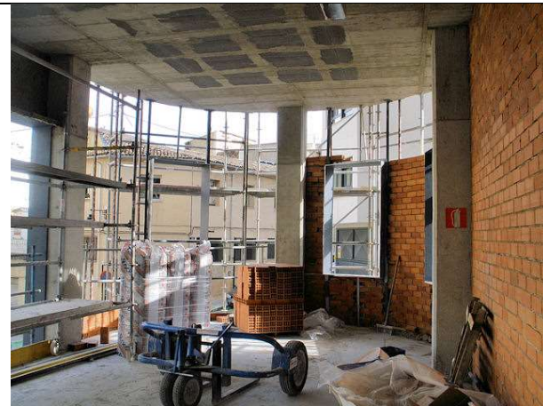
Elevación en la 3ª planta de la hoja exterior de la fachada con ladrillo hueco doble.
