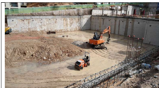
16 de marzo de 2012. Bloque 1: Vertido pilares HA-30/B/12/IIa sótano -1. Armado de muro de sótano de la fachada oeste
