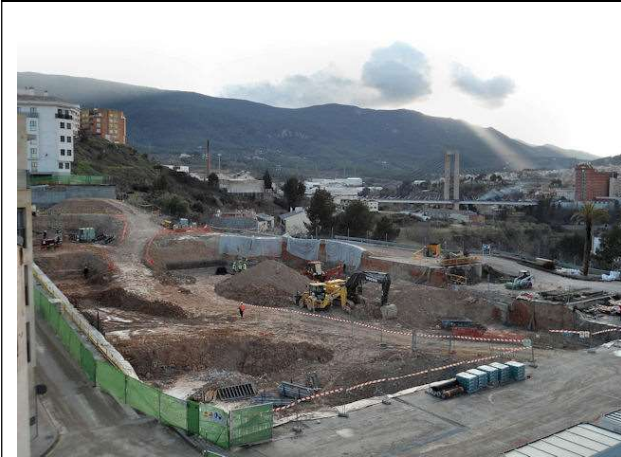
18 de enero de 2012. Excavación para ejecución de los anclajes en el bloque 2 del pabellón polideportivo. Vista general.
