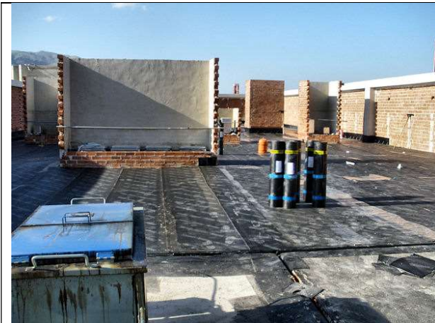
BLOQUE 1. Continúa la impermeabilización de la azotea en la PAC. Correcciones en encuentros.
