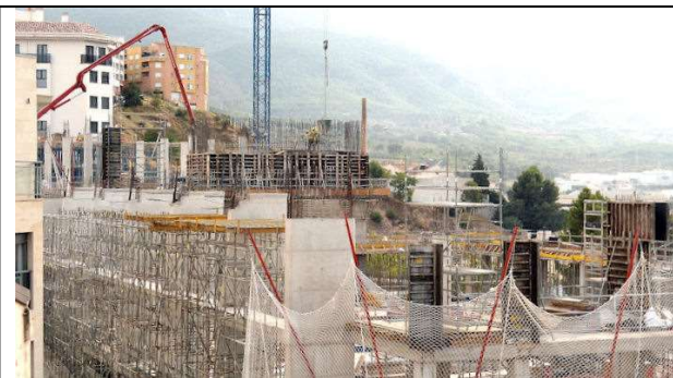
21 de septiembre de 2012. Bloque 1; Planta 3ª: Detalle del bombeo de hormigón del núcleo de caja de escalera y ascensores. Ejecución de pilares del forjado 6º
