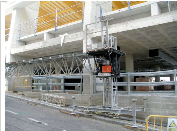
Montaje de plataformas motorizadas bimástil y monomástil en retranqueos de fachada en la calle Alarcón. (Las bases de madera deben cambiarse)
