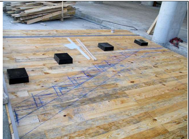
Replanteo de la escalera 3
