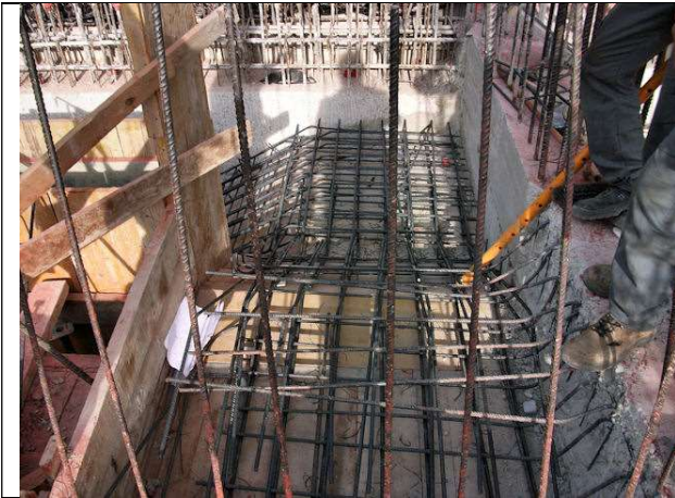
31 de mayo de 2012. Bloque 2: Armado de la escalera 2 que comunica las plantas de garaje -3 y -2
