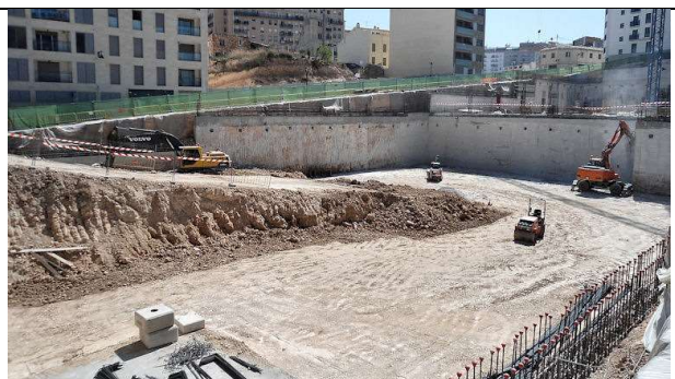
16 de marzo de 2012. Bloque 2: Compactación del propio terreno mediante rodillo vibrante tándem autopropulsado.
