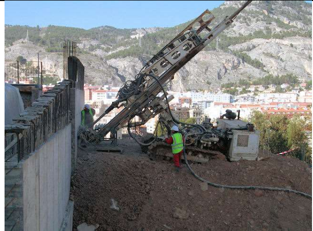
23 de enero de 2012. Perforación para anclajes permanentes de la fachada sur del edificio nuevo.
