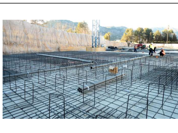
27 de febrero de 2012. Armado de la losa 1. Colocación de la toma de tierra y conducciones de la red de desagüe.
