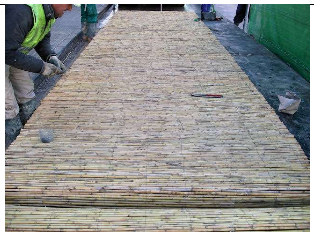
18 de enero de 2012. Preparación de muro de sótano para acabado visto con cañizo en planta de garaje -1
