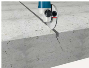
1. Apertura de caja de fisura con radial angular.
