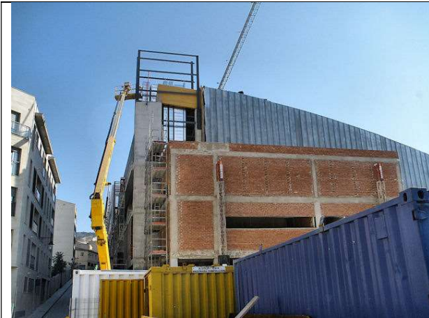
BLOQUE 2. Finalización de estructura metálica soporte de los cerramientos de las chimeneas.
