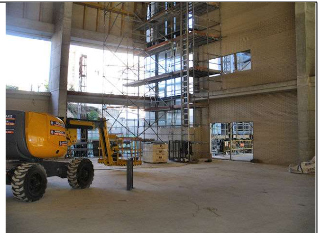
BLOQUE 2: Montaje del andamio e inicio del forro de ladrillo cara vista de \frac{1}{2} pie de las chimeneas.
