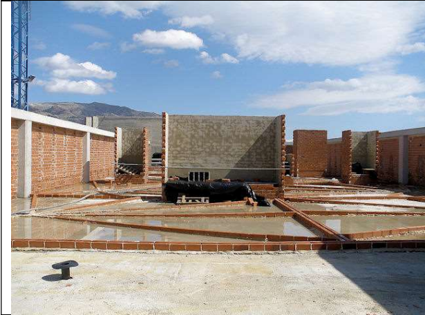
BLOQUE1. Formación de pendientes de las cubiertas invertidas.
