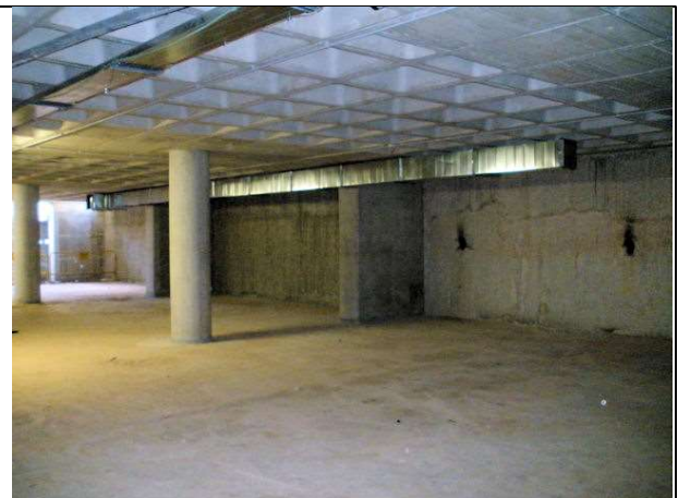
Comprobación del replanteo y comienzo de ejecución conducciones de ventilación de garaje en sótano -1.
