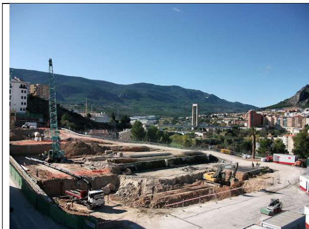
16 de noviembre de 2011. Vista general de la ejecución de muretes guía, vaciado del solar y demolición.
