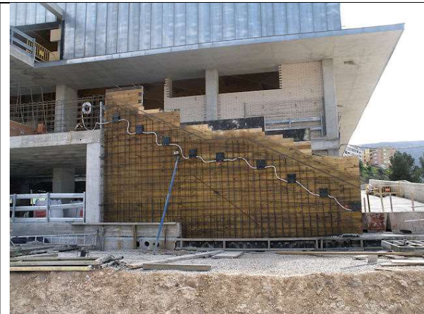
BLOQUE 2: Ejecución del muro de hormigón armado de apoyo de la escalera exterior 1
