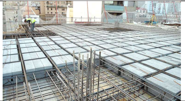
11 de octubre de 2012 Bloque 1: Detalle de armado del forjado 6º en el borde de la fachada este, a lado de la junta estructural del bloque 2
