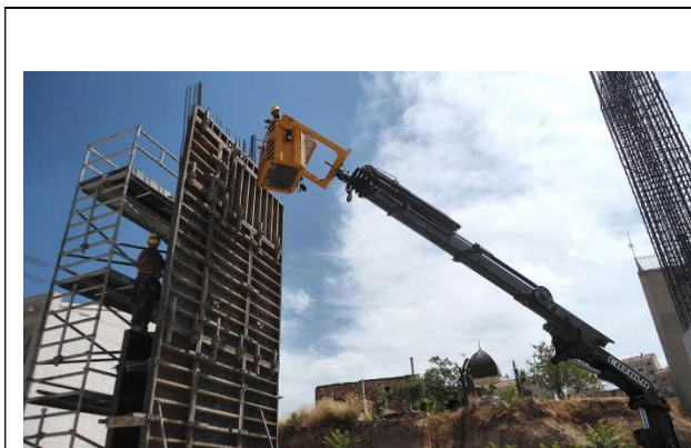
13 de agosto de 2013. B2 Pabellón: Cesta elevadora de brazo telescópico auxiliar para montaje de encofrado de pilares.
