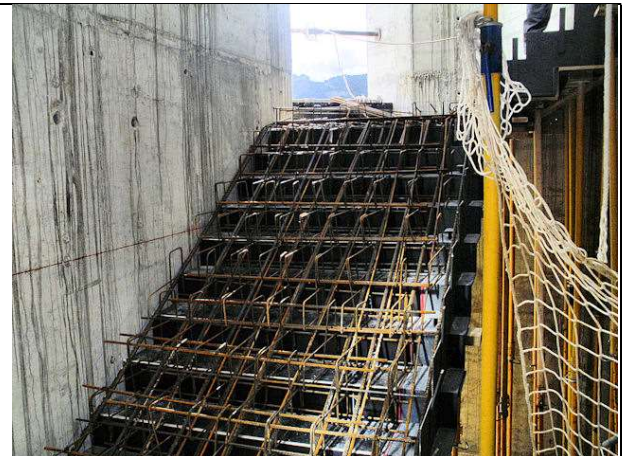
BLOQUE 1: Armado de la escalera 1 en el núcleo central de pantallas.
