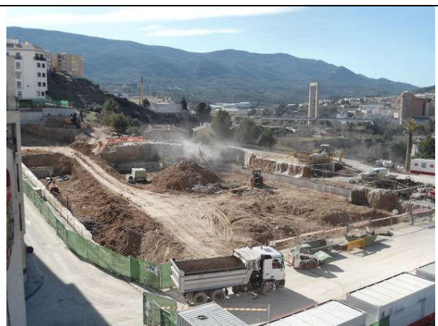
31 de enero de 2012. Excavación para finalizar anclajes en el bloque 2 y comenzar el vaciado en el edificio nuevo (Bloque1).
