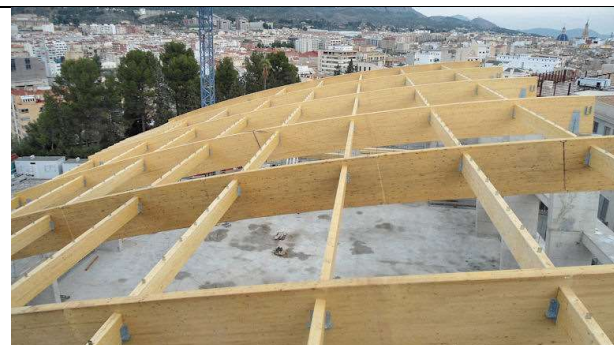
21 de noviembre de 2012. Finaliza la disposición de las correas, falta atornillar las diagonales para rigidizar los pórticos en los extremos.
