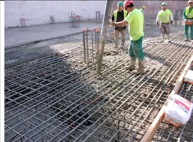
29 de febrero de 2012. Inicio hormigonado de la losa 1. HA-30/B/20/IIa+Qa. Aditivo impermeabilizante VANDEX.
