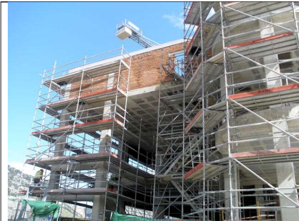
Ejecución hoja exterior de ladrillo hueco en la fachada SUR.
