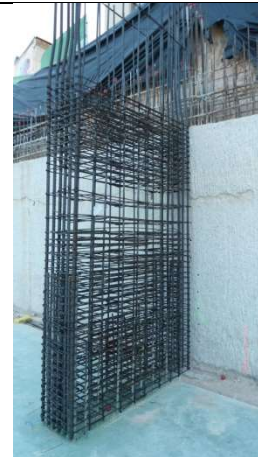
7 de mayo de 2012. Repicado y eliminación del coloreado sobre la base del pilar y armado de pilares de sótano -3.
