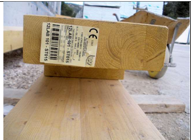
Recepción de últimos cabios de la fachada, base del soporte para el cerramiento.
