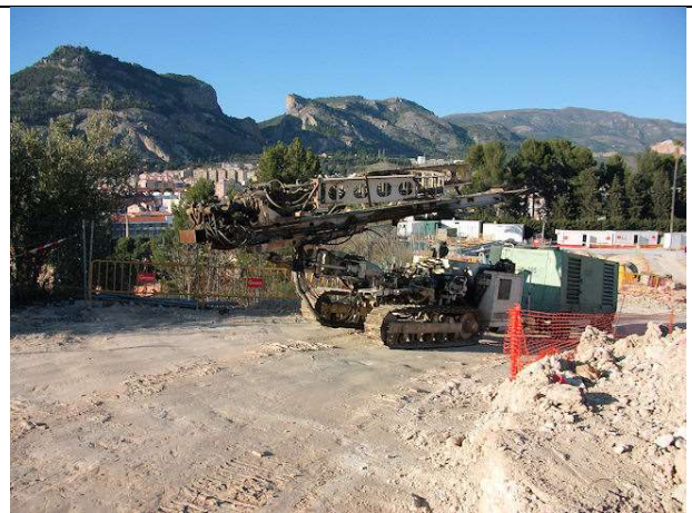
Lunes, 9 de enero de 2012. (15:45 h) Transporte montaje y preparación del equipo de perforación y tesado de anclajes.
