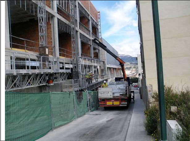
Colocación de cargaderos y premarcos en la fachada este C/ Alarcón.
