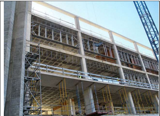
BLOQUE 1: Fachada oeste. Colocación de premarcos de la carpintería y cargaderos para apoyo de la fábrica.
