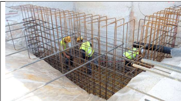
10 de abril de 2012. Armado foso de aljibe.
