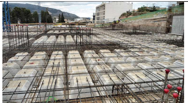
21 de mayo de 2012. Bloque 2 Forjado 1º: Finalización del armado de la fase 2ª.
