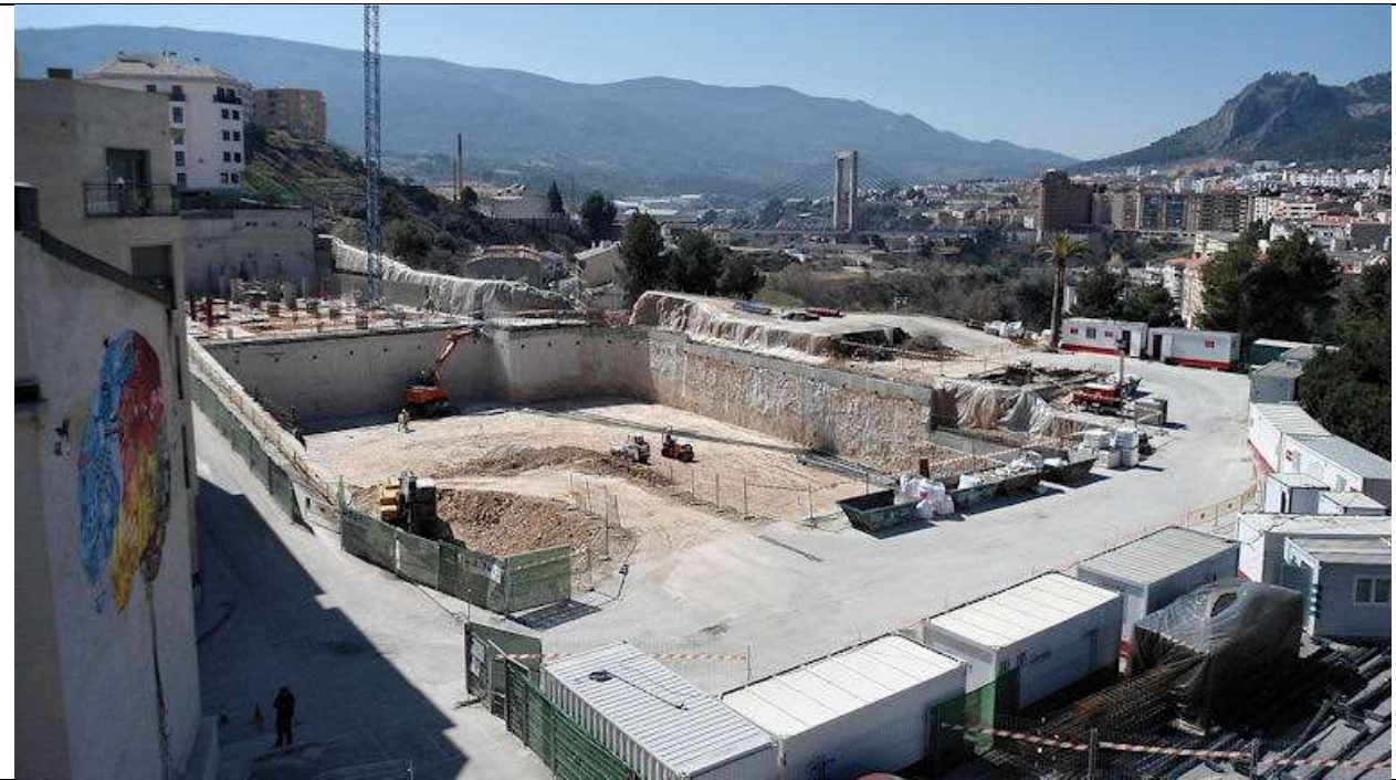
16 de marzo de 2012. Vista general del estado de la obra.
