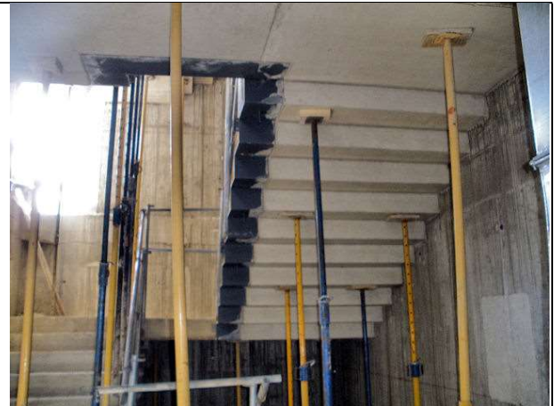
BLOQUE 1. Desencofrado de tramos de Planta Baja. Encofrado del último tramo hasta PAC 23 .
