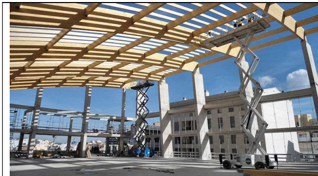
23 de noviembre de 2012. La colocación de los cabios es rápida. Menos de 2 días.
