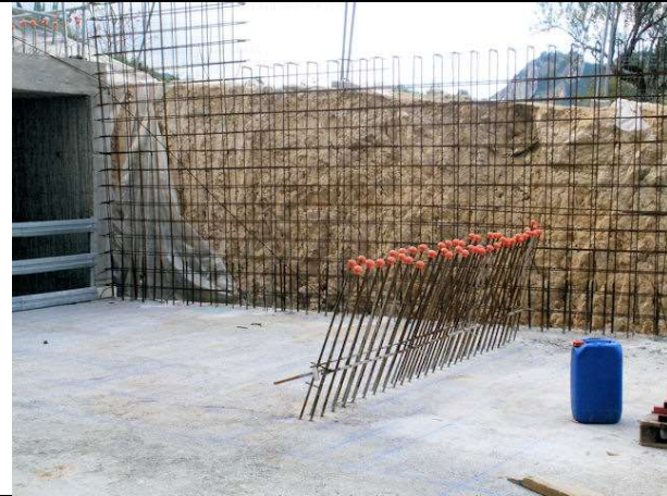
Replanteo de muros de soporte para escalera exterior 3 de planta baja.
