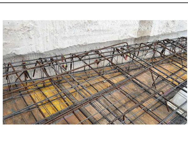
3 de abril de 2012. Bloque1: Conexión del forjado 3 inyectando resina epoxi en las perforaciones.
