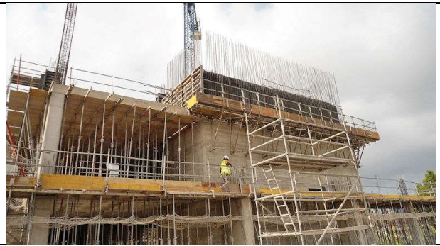
19 de septiembre de 2012. Bloque 1; Planta 2ª: Arranque de los muros del núcleo central para apoyo del forjado 6.
