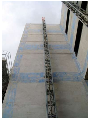
OESTE: Colocación malla de fibra de vidrio y mortero hidrófugo soporte del enformado monocapa.
