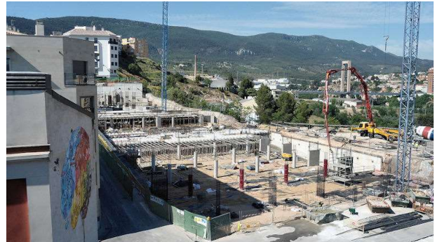
1 de junio de 2012. Inicio del encofrado del forjado 2 (B2) que acaba al mismo nivel del pavimento de la losa 1 (B1)
