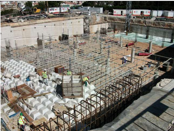
8 de mayo de 2012. Bloque 2: Avance del forjado 1
