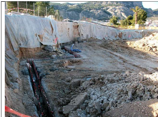
Lunes, 9 de enero de 2012. Hormigonado y conclusión de los últimos paneles de muro pantalla de la fachada oeste del pabellón
