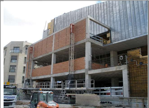
BLOQUE 2: En proceso de ejecución la hoja exterior de la fachada norte.
