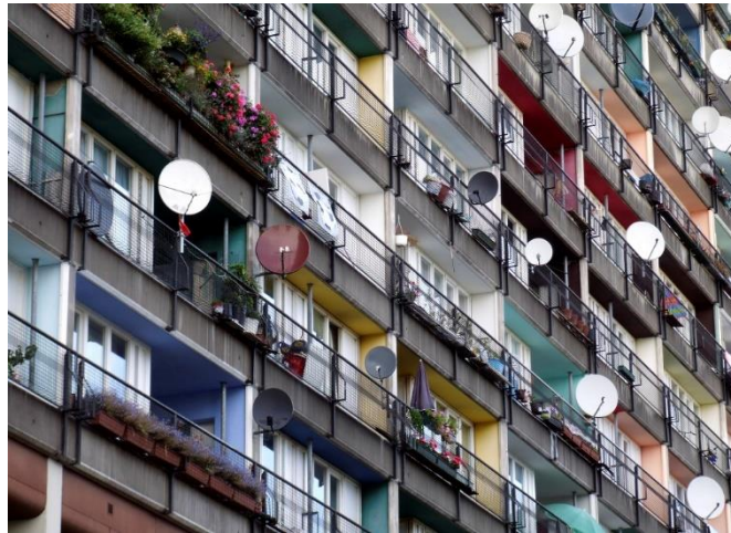
Figura 1. Fachada edificio con antenas parabólicas
