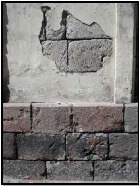
Gráfico 33 Base de piedra andesita al parecer de un Muro DE PISHILATA típico de estas construcciones. Fuente: Ayuntamiento de Ambato
