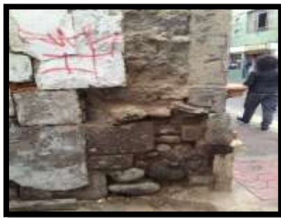
Gráfico 30 Muro DE PISHILATA típico de estas construcciones. Fuente: Ayuntamiento de Ambato
