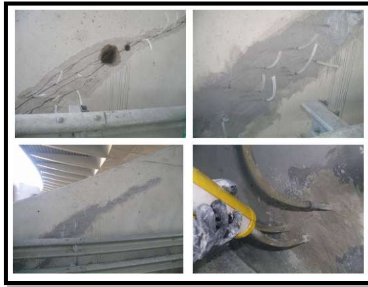
Gráfico 6 Inyección de fisuras con resina. Fuente: Ayuntamiento de Ambato
