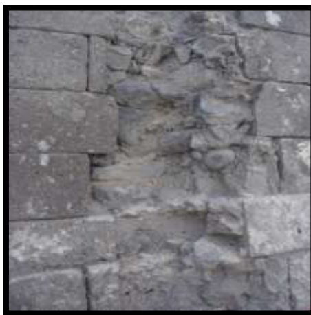
Gráfico 32 Muro DE PISHILATA típico de estas construcciones con conglomerado interior heterogéneo. Fuente: Ayuntamiento de Ambato
