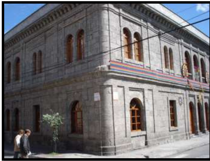
Gráfico 34 Construcción más o menos uniforme de este tipo de construcciones.
