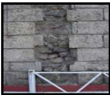
Gráfico 31 Muro DE PISHILATA típico de estas construcciones. Fuente: Ayuntamiento de Ambato
