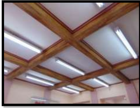
Gráfico 28 Vigas del Hall de ingreso de hormigón armado con acabado de madera. Fuente: Ayuntamiento de Ambato
