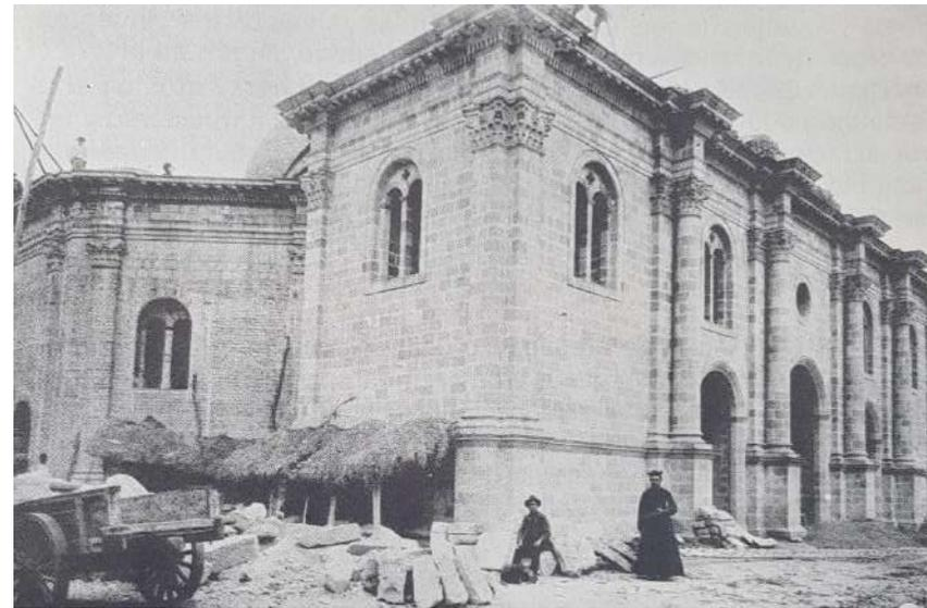
*Imagen 117. Construcción de la fachada y paredes laterales de la basílica del Sagrado Corazón de Jesús.*
