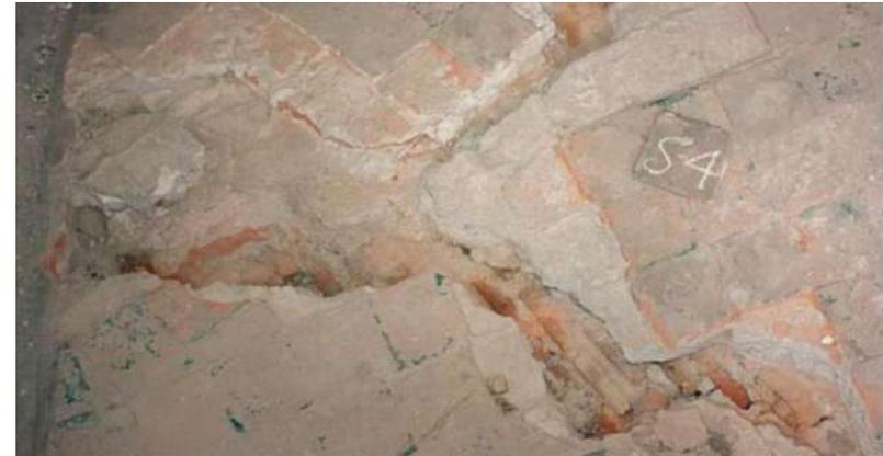
*Imagen 48. Vista desde arriba de una Nave lateral, por las grietas nos podemos dar cuenta del ladrillo que utilizaron para su construcción.*
