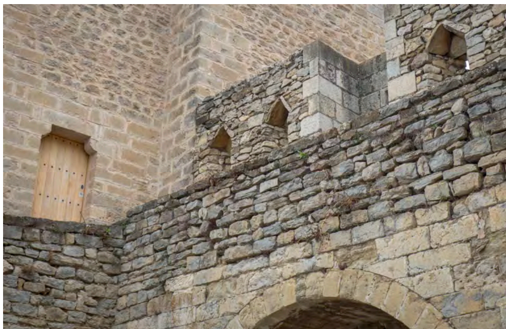
FIGURA 86. Façana interior del Portal del Forcall (S. Portela, 2018).
