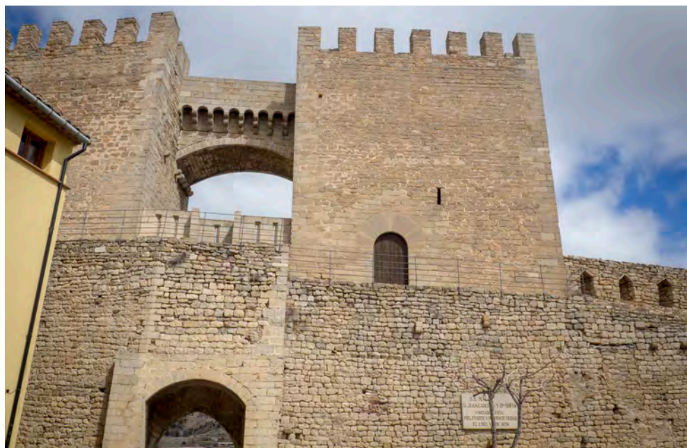
FIGURA 140. Façana interior del Portal de Sant Miquel (S. Portela, 2018).
