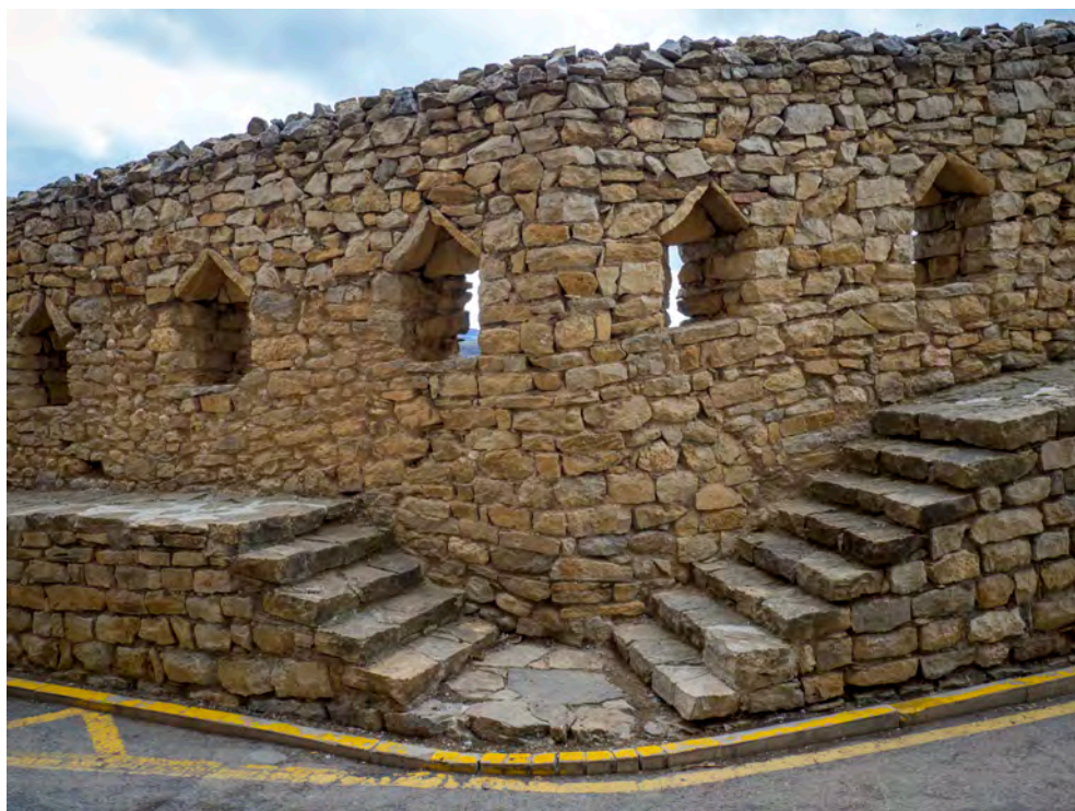
FIGURA 4. Detall de la banqueta de la muralla entre el Portal de Sant Mateu i la Torre Beneito (S. Portela, 2018).
