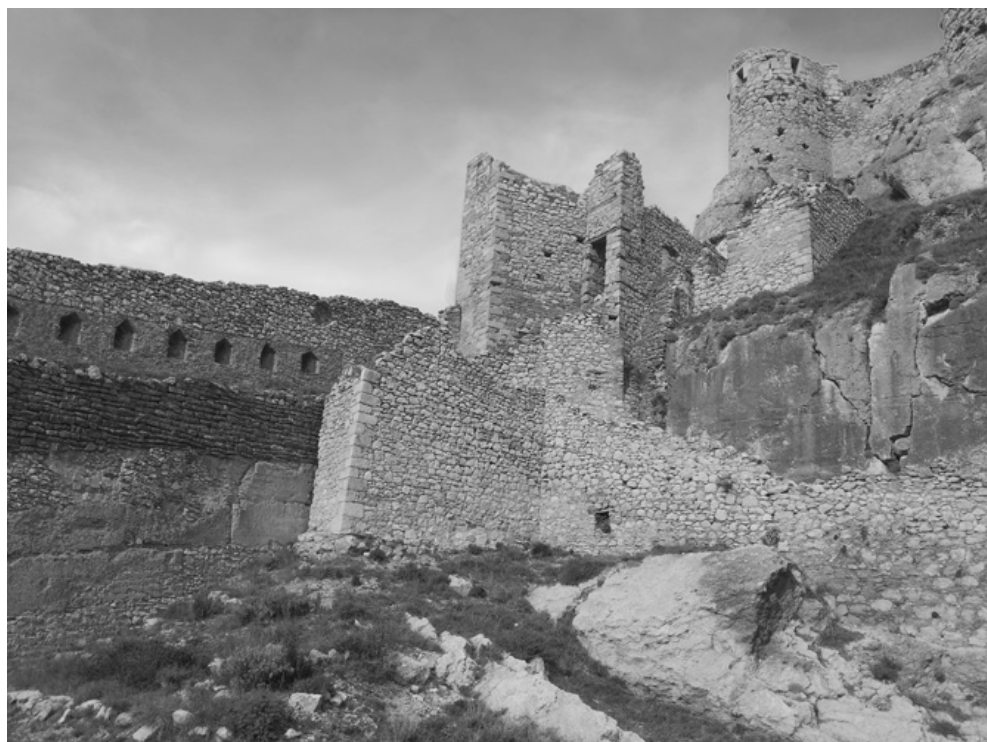
FIGURA 61. Estat actual de la Torre de Sant Francesc, vista des de l'interior de les muralles (Font: Carquero Arquitectura).
