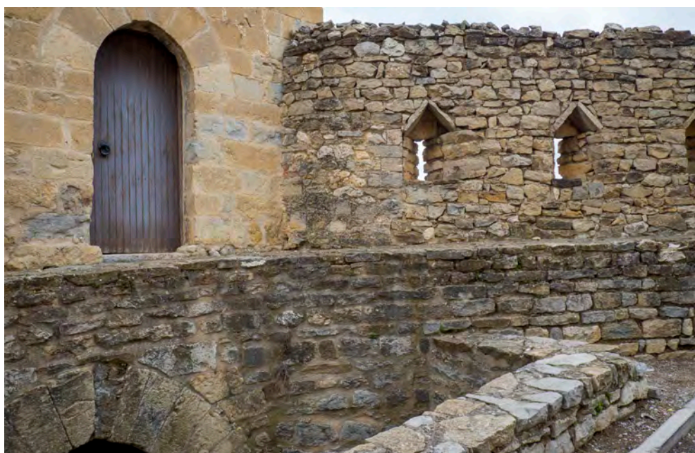
FIGURA 95. Detall de la façana interior de la Torre de Fredes, accés en planta primera a través de la banquetta (S. Portela, 2018).
