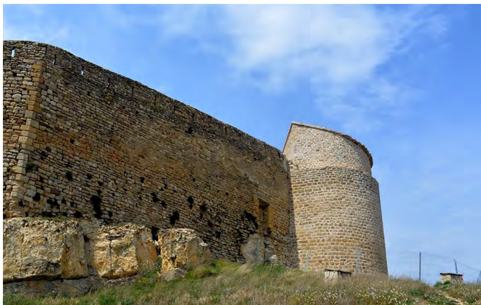
FIGURA 134. Vista de la Torre Redona des de l'exterior de les muralles, després de la intervenció (Diari del Maestrat, 2019).
