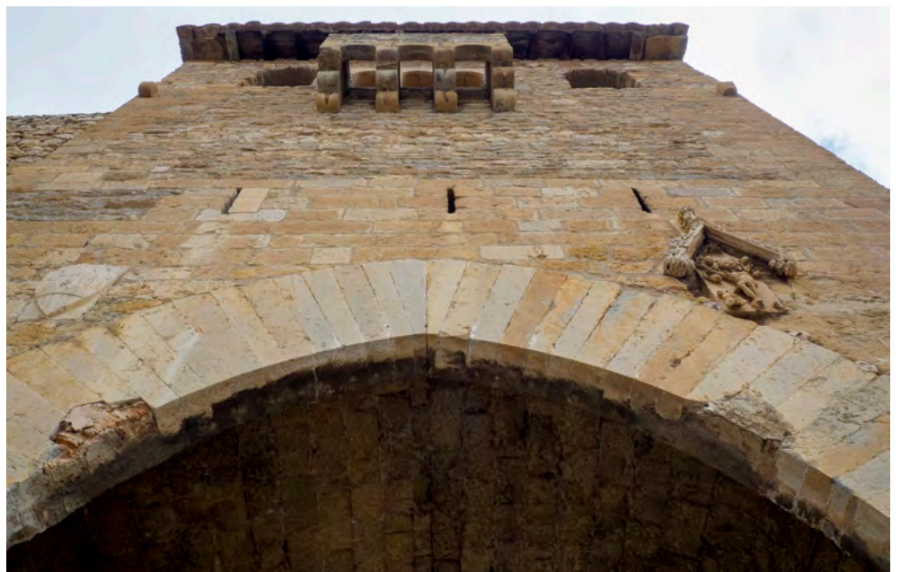
FIGURA 101. Façana exterior del Portal de Sant Mateu, detall del matacà defensiu i els escuts (S. Portela, 2018).
