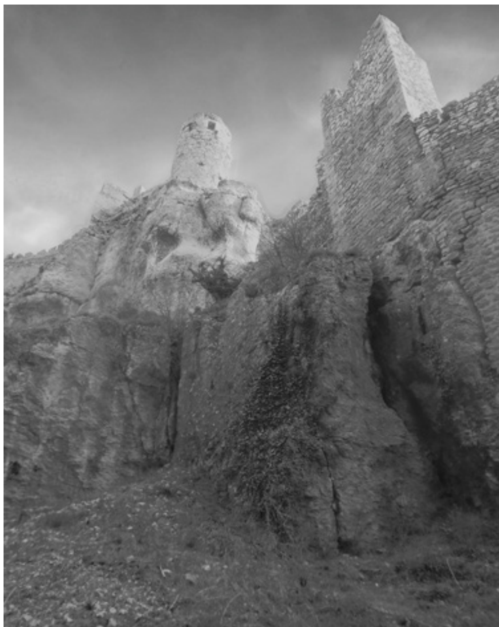
FIGURA 62. Vista de la Torre de Sant Francesc des de l'exterior de les muralles (Font: Carquero Arquitectura).
