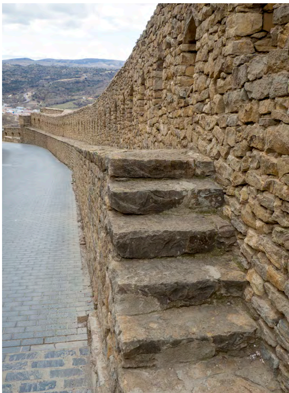
FIGURA 54. Tram de muralla entre el Portal del Forcall i la Torre de Fredes (S. Portela, 2018).
