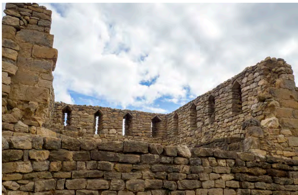
FIGURA 121. Espitlleres i banqueta de la planta de coberta de la Torre de l'Asperó (S. Portela, 2018).
