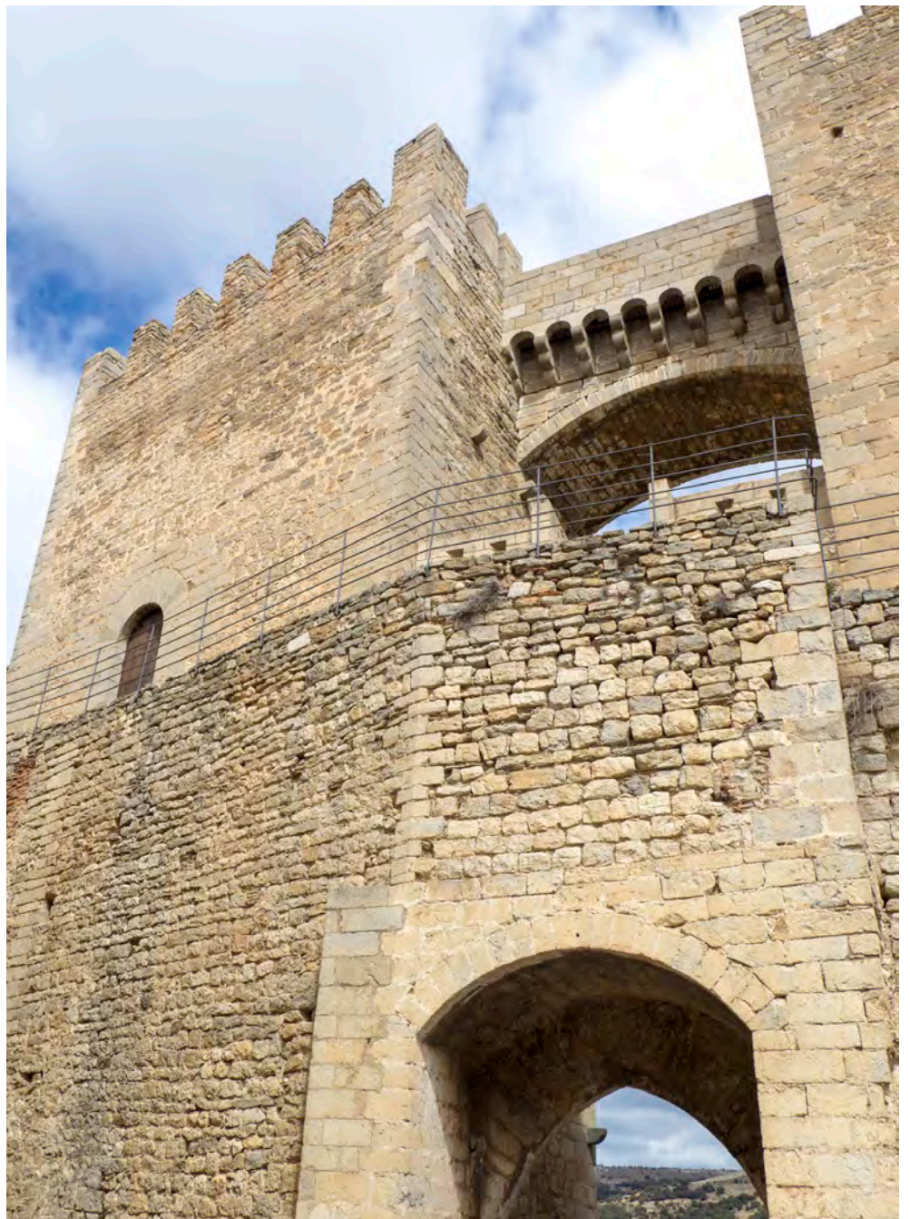
FIGURA 143. Façana interior del Portal de Sant Miquel (S. Portela, 2018).
