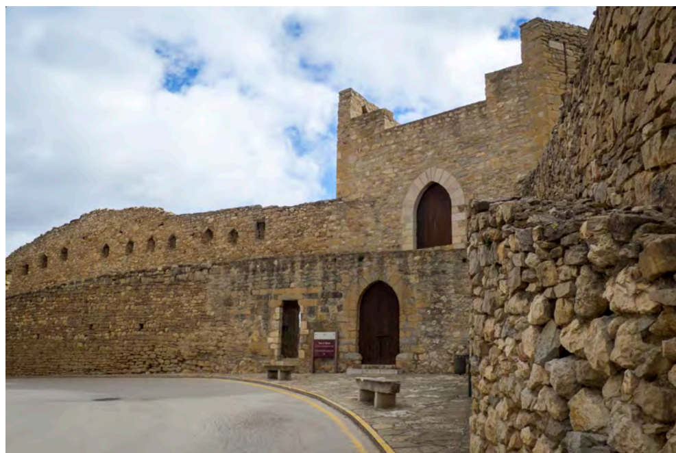
FIGURA 41. Vista de la façana d'intramurs de la Torre Beneito (S. Portela, 2018).
