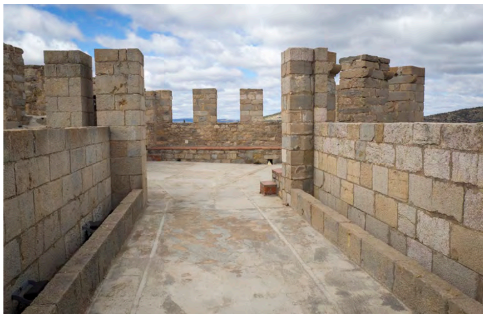
FIGURA 141. Planta de coberta del Portal de Sant Miquel, detall dels merlets i els matacans (S. Portela, 2018).
