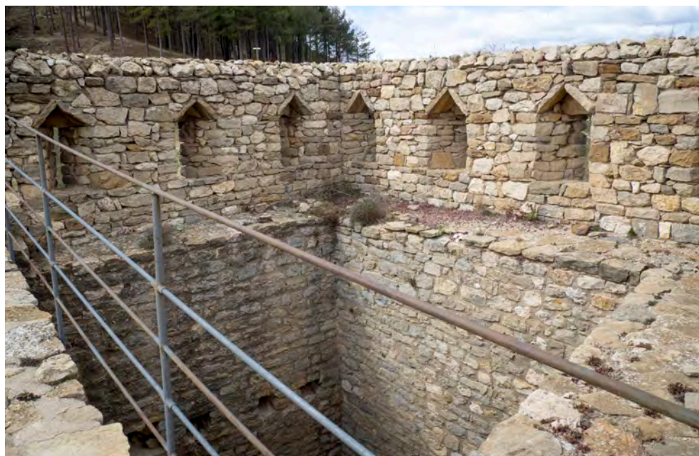
FIGURA 155. Torre oest del Portal de la Nevera, sense coberta ni forjats interiors. Detall de les espitlleres. (S. Portela, 2018).
