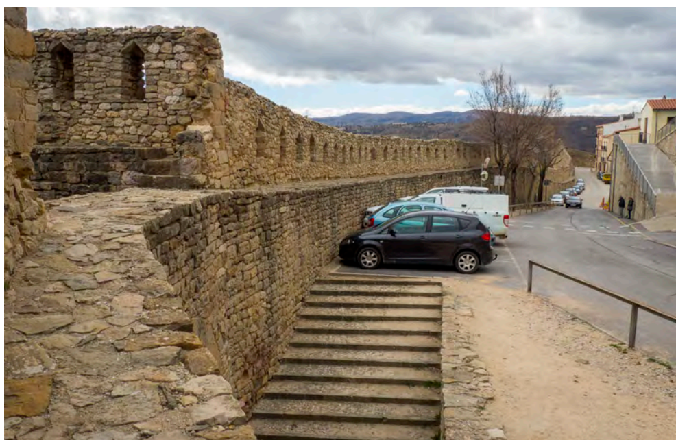
FIGURA 123. Banqueta de la muralla en la Torre de l'Asperó (S. Portela, 2018).
