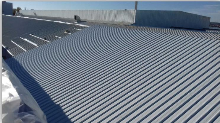
Figura 3: Cubierta de chapa simple. (Fuente Lymsa)
