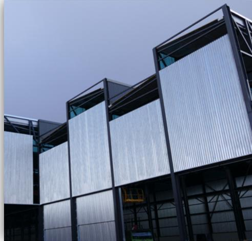
Figura 9: Fachada de chapa simple. (Fuente IncoPerfil).
