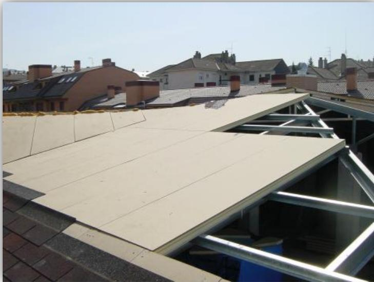
*Figura 5: Cubierta inclinada sándwich metálico. (Fuente Lymsa).*
