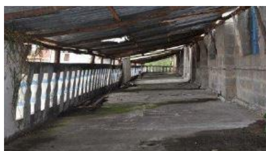
Ilustración 58. Cubierta provisional Fuente: GAD Municipal de Azogues
