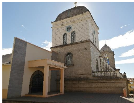
Ilustración 139. Estado actual, 2019 Fuente: autor, Calle G., 2019
