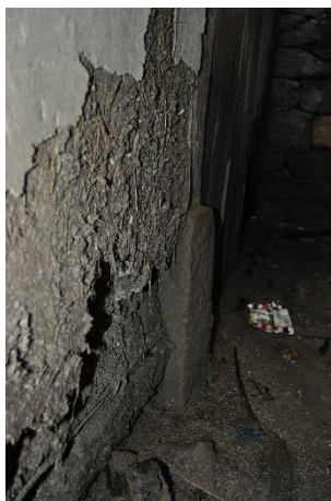
Ilustración 92. Constitución de cimentación de convento Fuente: autor, Calle G., 2019
