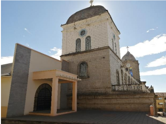
Ilustración 95. Tonalidades en la iglesia Fuente: autor, Calle G., 2019
