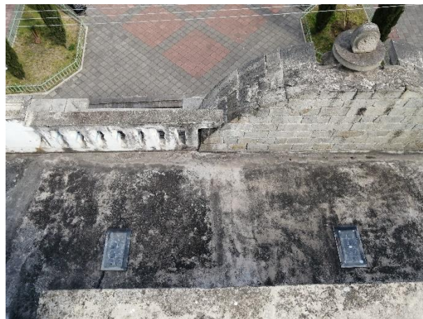
Ilustración 111. Cubierta lateral de iglesia Fuente: autor, Calle G., 2019
