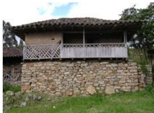
Ilustración 36. Vivienda compacta en Cojitambo Fuente: INPC, 2011
