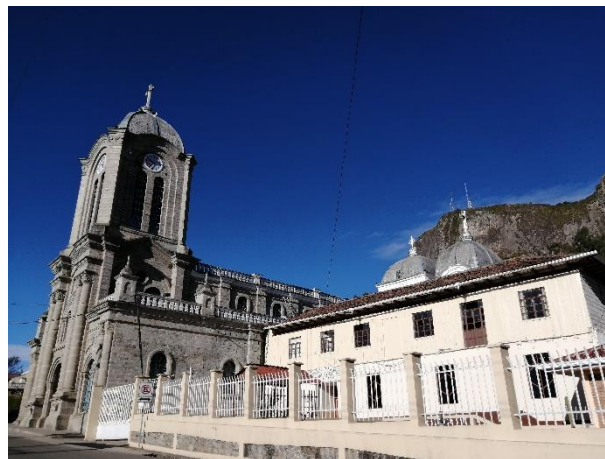
Ilustración 94. Iglesia y convento – diferentes técnicas constructivas Fuente: autor, Calle G., 2019
