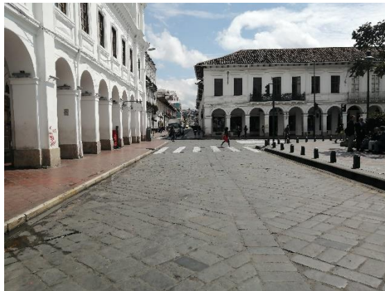
Ilustración 26. Empleo de adoquines en centro histórico de Cuenca Fuente: autor, Calle G., 2019
