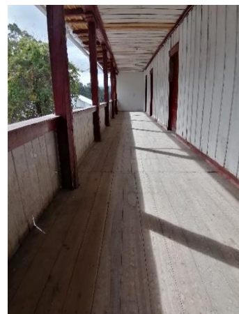
Ilustración 101. Revestimiento de piso original Fuente: autor, Calle G., 2019
