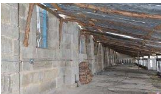
Ilustración 57. Cubierta provisional Fuente: GAD Municipal de Azogues
