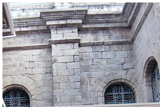
Ilustración 137. Estado actual, 2019 Fuente: autor, Calle G., 2019
