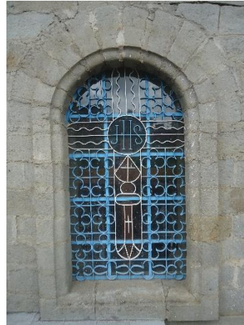
Ilustración 109. Ventana de hierro - iglesia Fuente: autor, Calle G., 2019
