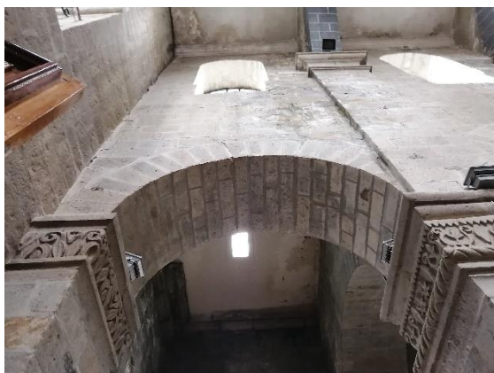
Ilustración 69. Composición de arco de medio punto Fuente: autor, Calle G.
