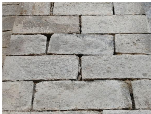
Ilustración 131. Estado actual, 2019 Fuente: autor, Calle G., 2019
