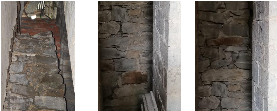
Ilustración 85 - 86 - 87. Cimentación de la Iglesia Fuente: autor Calle G., 2019
