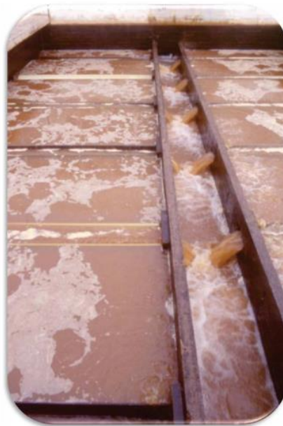
Figura 18. Filtración por gravedad [16]
