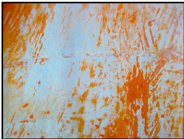
PROCESO DE INTERVENCIÓN
