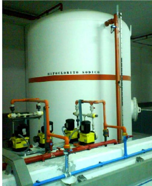
*Figura3.10.-fotografía de sistema para adición de hipoclorito sódico.*
