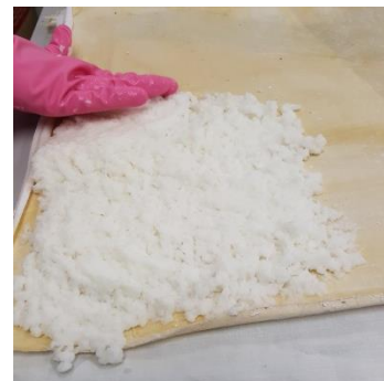
Fig. 52. Aplicación del empaco de pulpa de celulosa.
