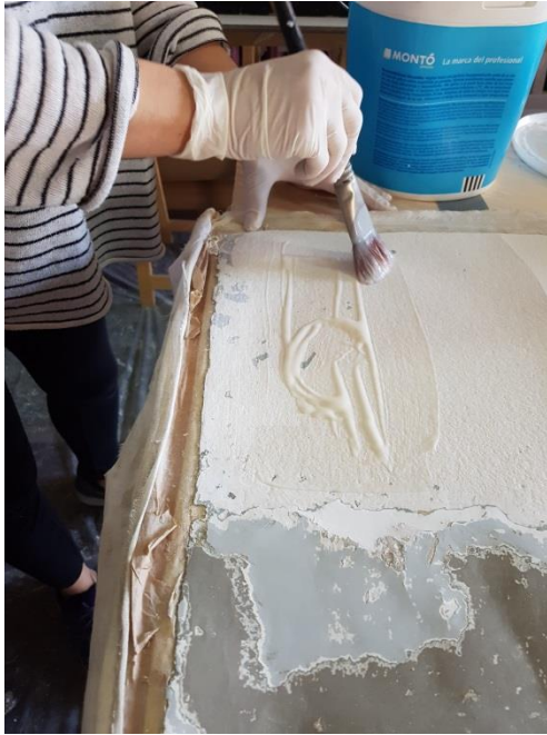
Fig. 70. Artista realizando las primeras pruebas con decapante de pintura sobre la pieza V.
