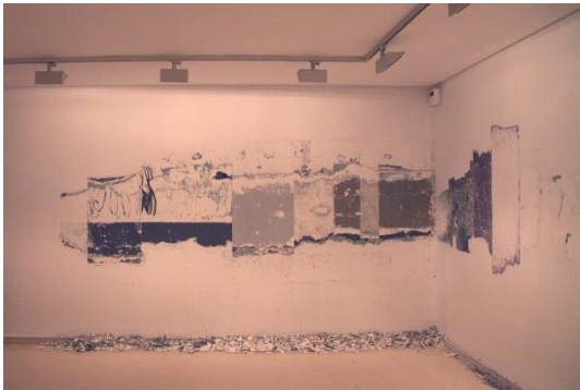
Fig. 7. Fotografía general de la pared puerta derecha. Pieza I.
