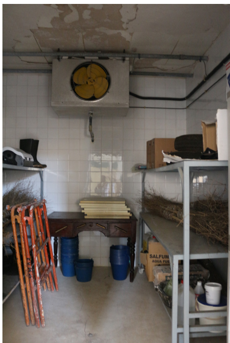
Figura 12: Estado actual de la antigua sala frigorífica.
