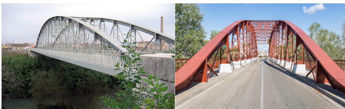
Figura 28: Puente de hierro, antes y después.
