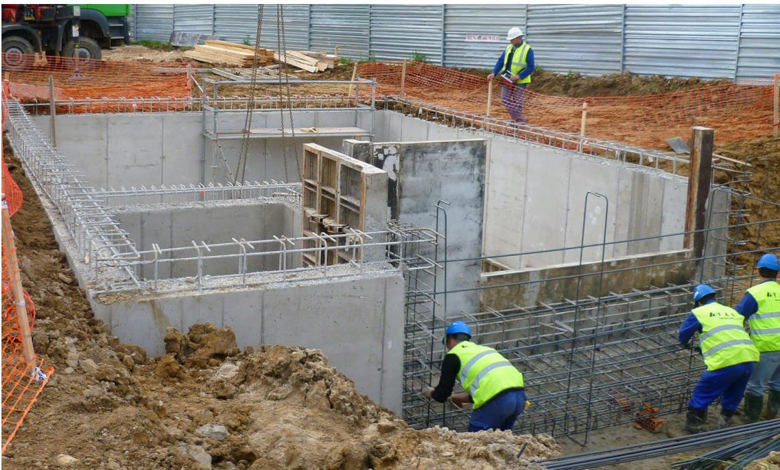
Figura I.10. Hormigón reforzado, encofrado de un edificio
