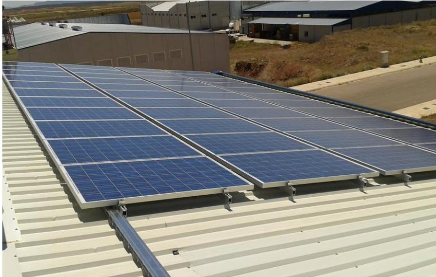
Imagen 7. Sistema coplanar con perfiles portantes
