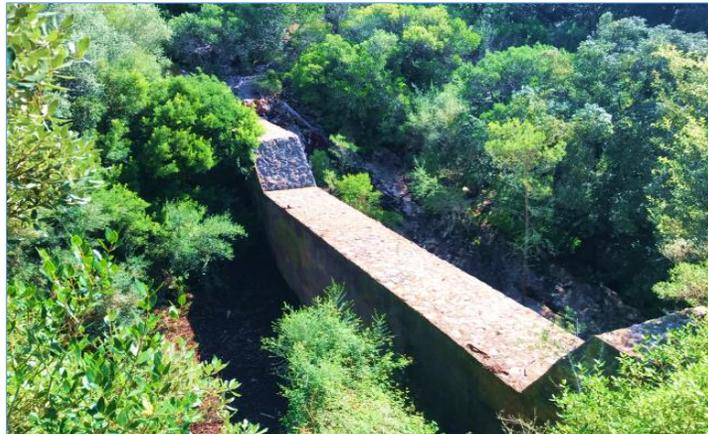
**Figura 14.** Presa de laminación y retención de sedimentos.
