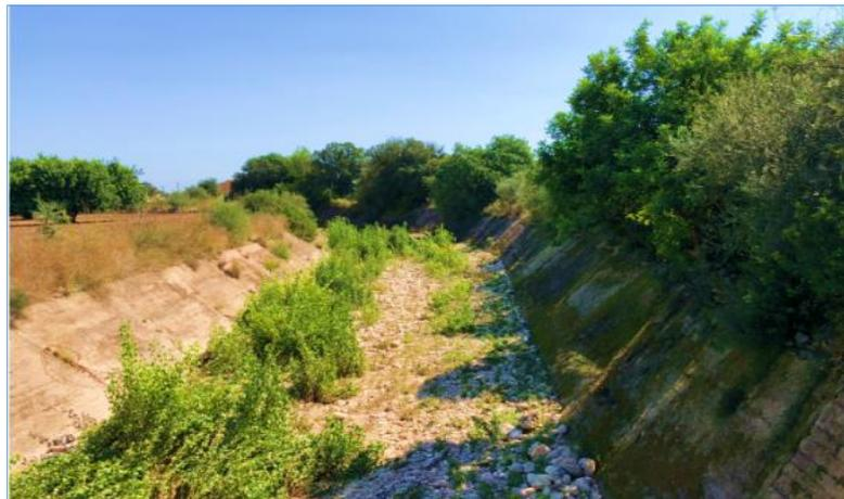
**Figura 20.** Márgenes canalizadas de hormigón.
