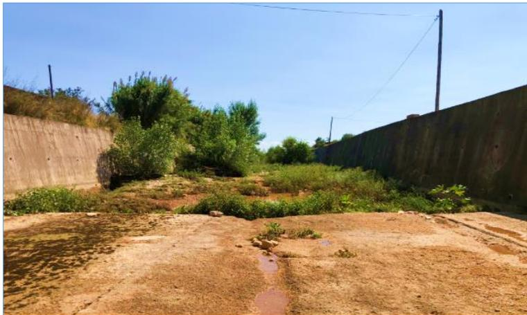
**Figura 18.** Aguas abajo del Puente de la autovía Ma-13 (Palma de Mallorca - Bahía de Alcudia). Se observa la canalización de hormigón del margen como del lecho.
