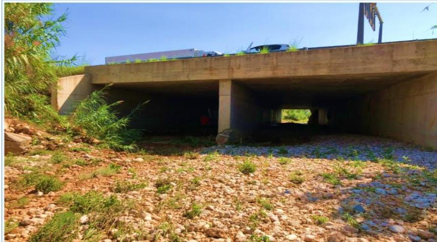
**Figura 21.** Aguas arriba del puente de la autovía Ma-13. Se observa la diferencia del espaciamiento de los cajones del puente, el de lado izquierdo se encuentra un poco obstruido por material que ha sedimentado, mientras el de lado derecho se encuentra despejado; pero presenta gravas en su interior.
