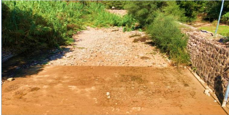
**Figura 17.** Estación de aforo San Miguel (Inicio del tramo de estudio). Se observa las márgenes canalizadas con piedra seca y una sección del lecho de hormigón. Se tienen una sección inicial rectangular.
