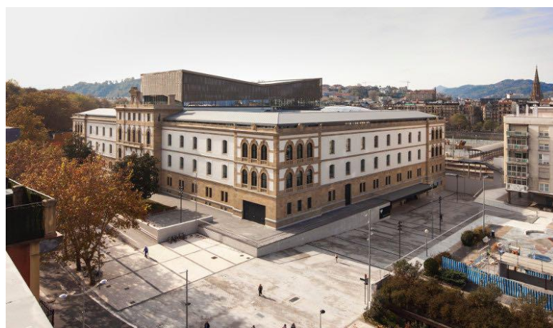
Img. 6. Exterior Tabakalera (San Sebastián). En: TABAKALERA Centro Internacional de Cultura Contemporánea [en línea].
