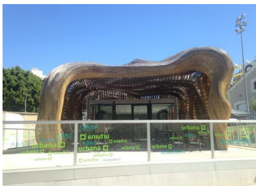
Img. 26. Cafetería en Las Cigarreras (Alicante), 2019. Elaboración propia.
