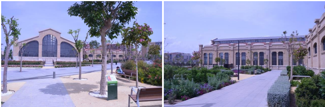
Img. 45 y 46. Vista frontal y lateral de parte de la Nave 1 del Parque Central (Valencia), 2019. Elaboración propia.
