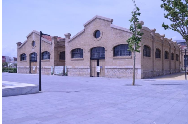
Img. 44. Naves 2 y 3 del conjunto de las Naves de Ribes, Parque Central (Valencia), 2019. Elaboración propia.
