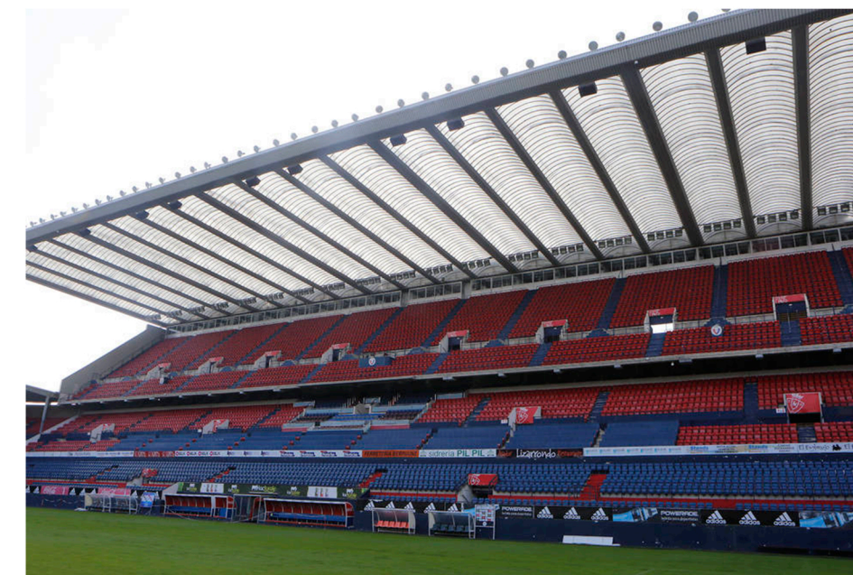
Figura 33. Fotografía de la cubierta que cubre tanto el primer, como el segundo anfiteatro de la tribuna.
