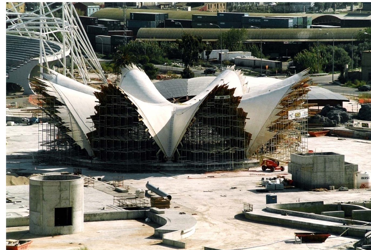
Se colocaron aspersores sobre la lámina hormigonada para realizar el curado.
