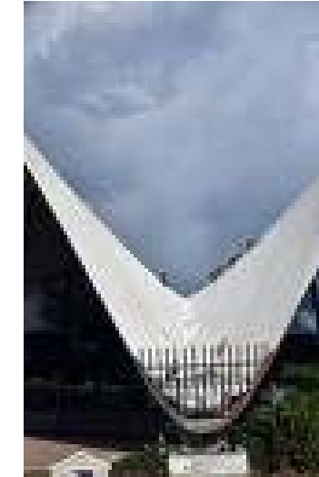
Apoyos Restaurante de los Manantiales, Xochimilco
