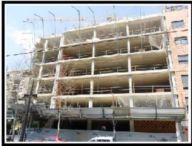
Figura 4.22. C/Doctor Vicente Zaragoza frente a la parada de tranvía de Benimaclet Fase en construcción Fuente:Propia
