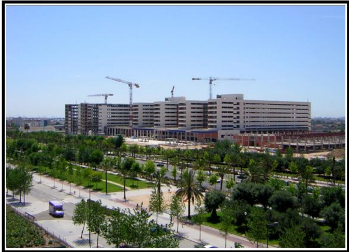
Figura 4.36 Hospital de la Nueva Fe Fuente: Ayuntamiento de Valencia
