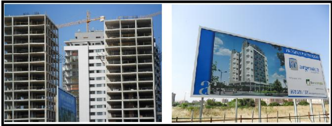
Figura 4.53 Argentea Residencial (en construcción). Ciudad de las Artes y las Ciencias Fuente: Propia
