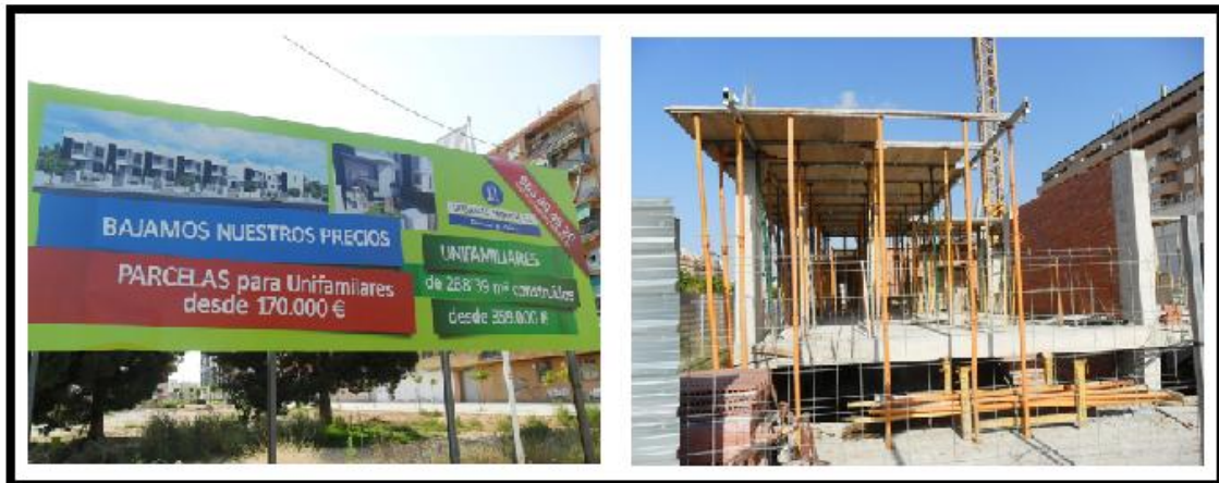
Figura 4.57. Alquería Benet, Chalets adosados. Valla publicitaria y chalets adosados en obra. Fuente: Propia
