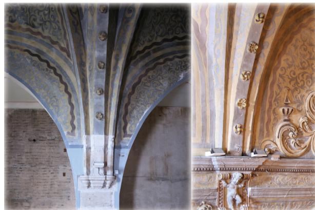
A la izquierda, arranque de nervios de las bóvedas de los dos primeros tramos de la iglesia y arranque del resto de bóvedas.
