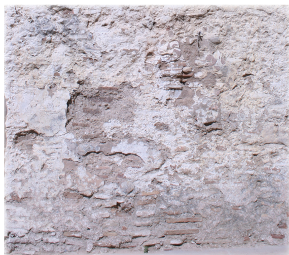
En la imagen se puede apreciar en la parte inferior las primeras cinco hiladas de ladrillo que forman el zócalo y en la parte superior, aunque un poco deteriorado se aprecia la tapia con tierra y ladrillos.
