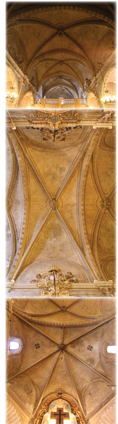
Bóvedas de crucería simple y poligonal de la iglesia y de la cabecera.
