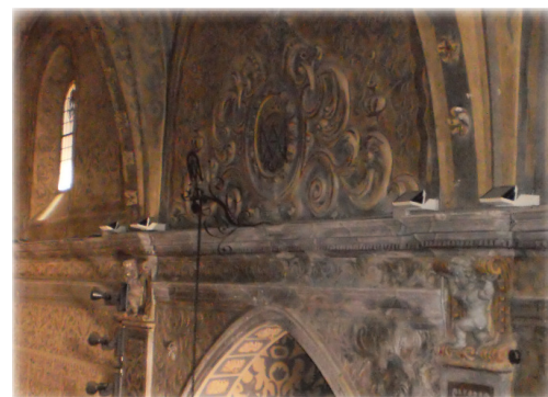
El resto de bóvedas del interior de la iglesia apoya sobre bandas decorativas, que son molduras anchas y de poco vuelo. La decoración simula capiteles.
