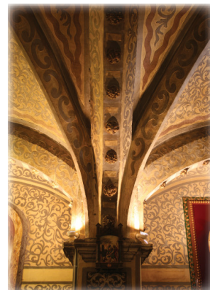
A la izquierda, arranque de nervios de las bóvedas de los dos primeros tramos de la iglesia y arranque del resto de bóvedas.
