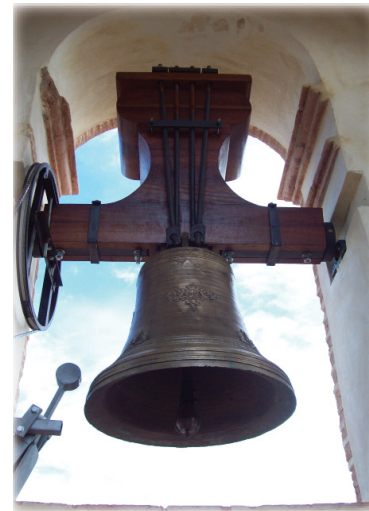
San Francisco: Diámetro - 860mm. Falda campana - 90mm. Altura vaso campana - 725mm. Peso aprox - 350kg. Última restauración - 1941.
