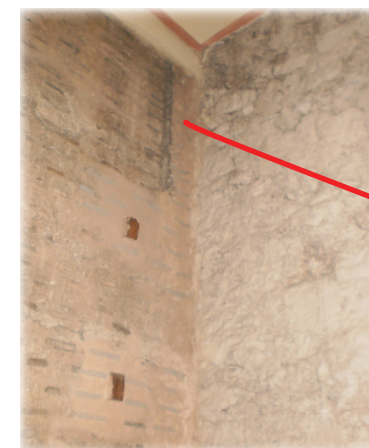
En algunos tramos del tapial, aun se pueden apreciar las marcas de los codales del encofrado y las tongadas.
