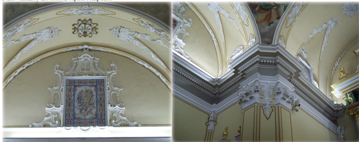
Falsa ventana y decoración capitel compuesto
