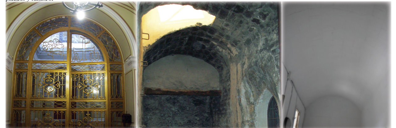
Bóveda cañón acceso capilla. bóveda con arco escarzano entre iglesia y claustro y bóveda con arco escarzano que cubre la escalera de acceso al campanario y claustro.
