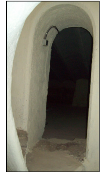
Acceso desde la torre a la alcoba.
