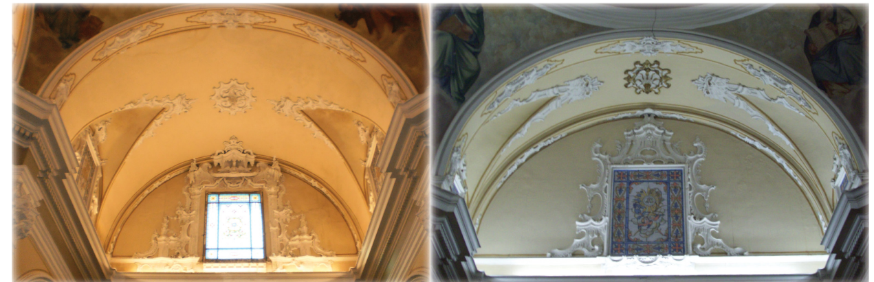
Bóvedas con lunetos de los brazos de la capilla de la comunión.
