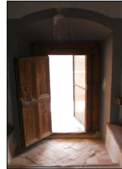
Acceso desde el coro al claustro.
