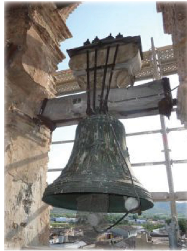
San Francisco: Diámetro - 860mm. Falda campana - 90mm. Altura vaso campana - 725mm. Peso aprox - 350kg. Última restauración - 1941.
