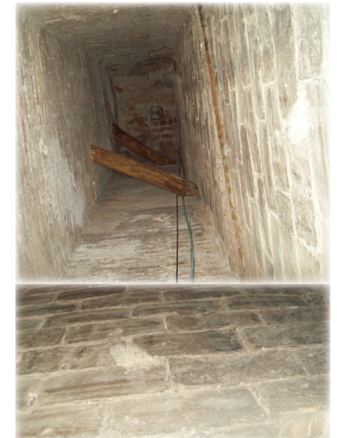
Tabique interior de la torre realizado a panderetes.
