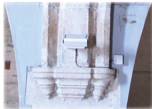
Las bóvedas del coro de la iglesia descansan sus nervaduras sobre ménsulas trilobuladas de traza cónico invertida.
