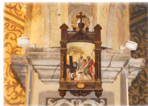
En los dos primeros tramos de la iglesia los nervios de las bóvedas apoyan sobre ménsulas de planta rectangular, como si de un trozo de banda decorativa se tratara.
