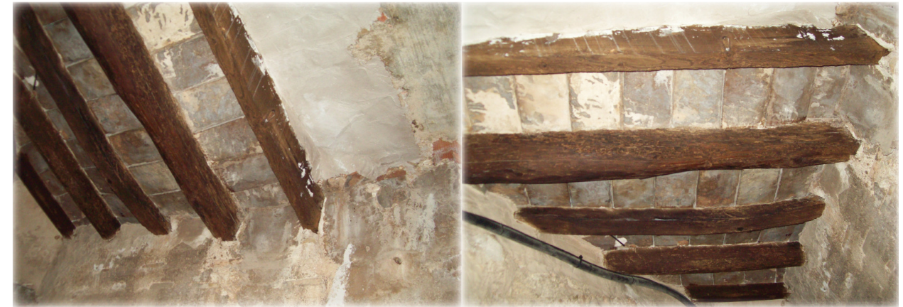
Forjado inclinado cubierta dependencias.
