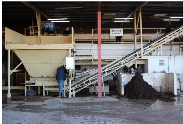
Ilustración 3: Tolva con la cinta transportadora y primera criba
