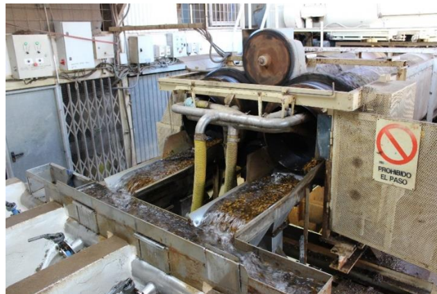
Ilustración 5: Tercer bombo, limpieza y ducha.
