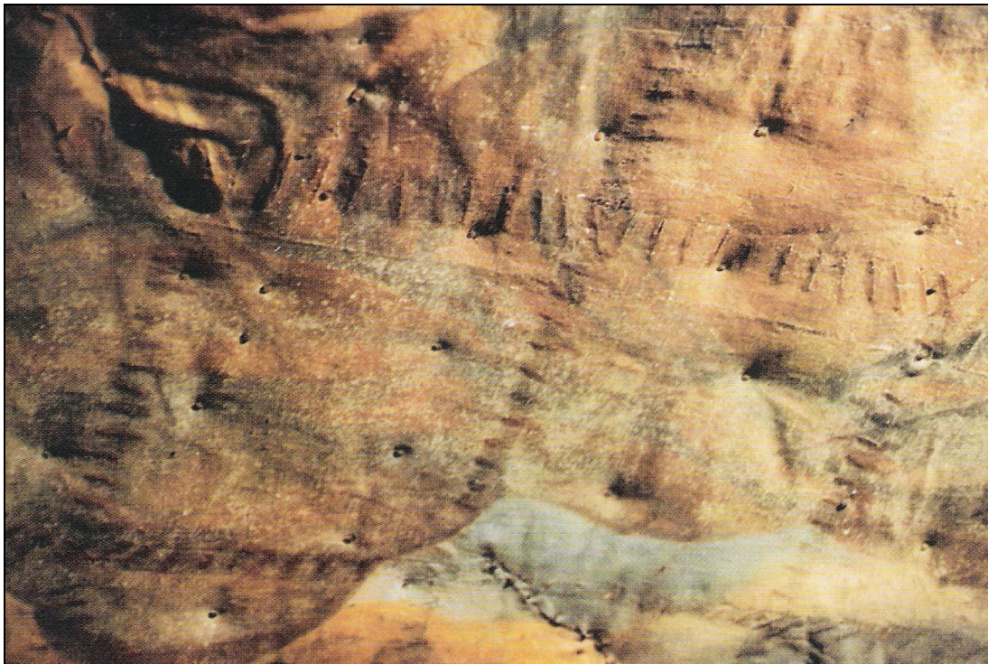
Fig. 24. Detalle de las costuras de las telas de la cúpula de Santa Chiara en Urbino, Italia.
