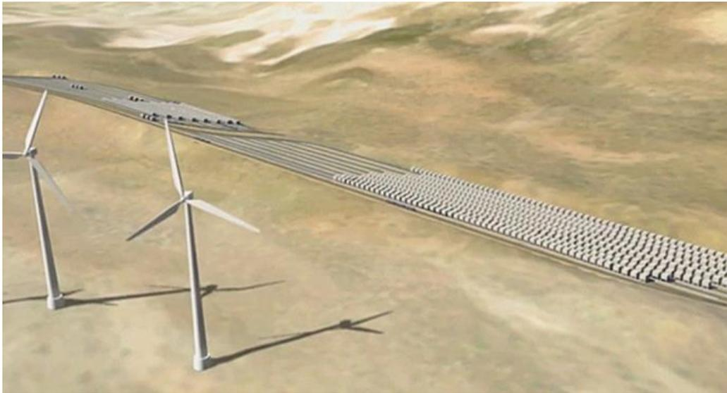
*Ilustración 10 Visualización de sistema avanzado ferroviario de almacenamiento de energía*
