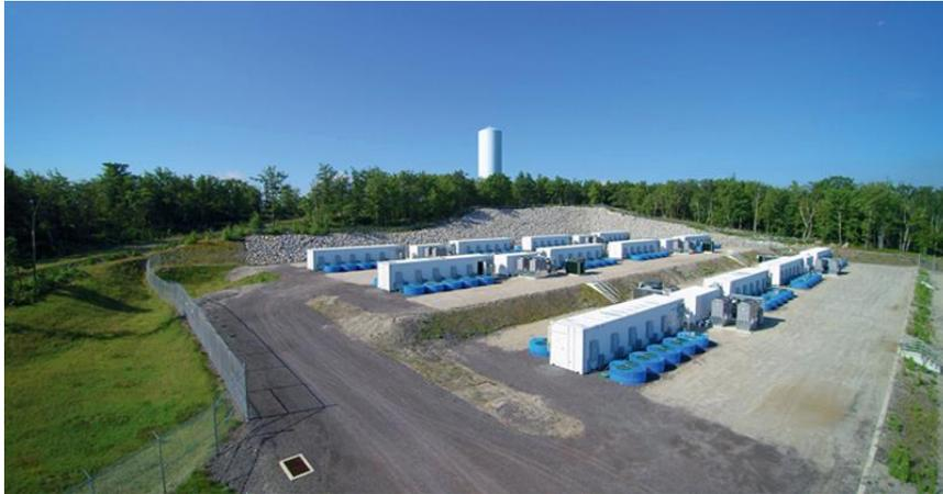
*Ilustración 48 Planta de regulación de red mediante volantes (20 MW)*
