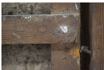
Fig. 46. Detalle de la unión del travesaño con el bastidor de la obra Salvador Mundi .
