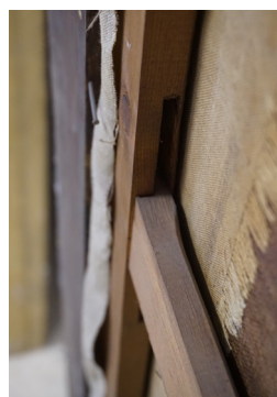
Detalle del ensamble del travesaño.
