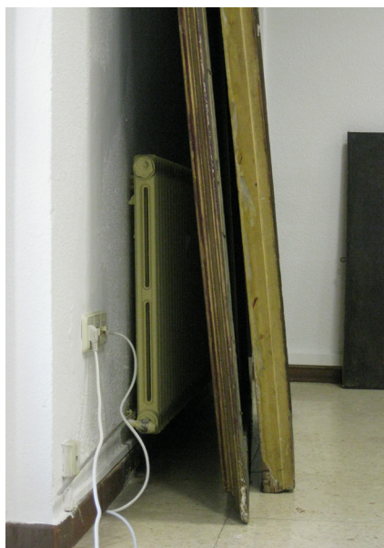
Fig. 26. Detalle de la base de la pared Sur.
