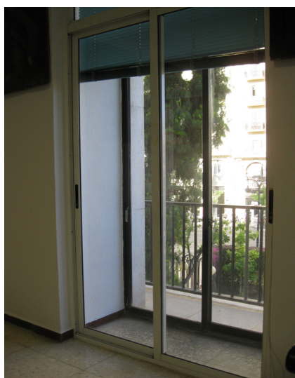
Fig. 22. Detalle de la ventana del lado derecho de la pared Sur.
