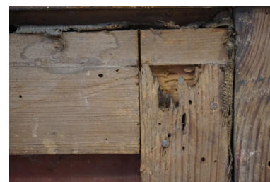
Detalle del ensamble del bastidor.
