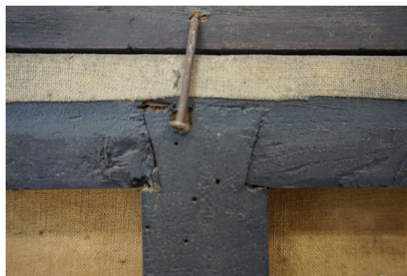
Detalle del ensamble del travesaño.
