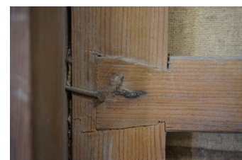
Detalle del ensamble del travesaño.
