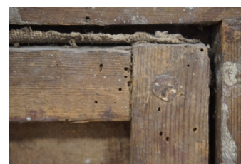
Detalle del ensamble del bastidor.
