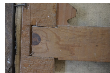
Detalle del ensamble del travesaño.
