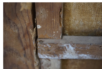
Detalle del ensamble del travesaño.
