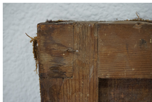
Detalle del ensamble del bastidor.
