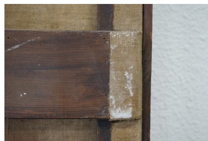
Detalle del ensamble del travesaño.
