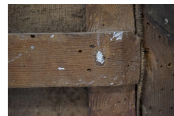
Detalle del ensamble del travesaño.
