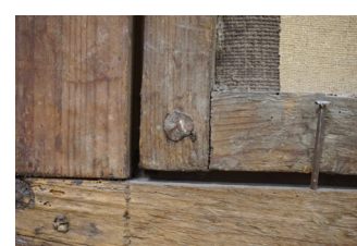
Detalle del ensamble del bastidor.
