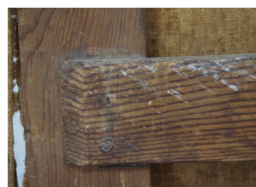
Detalle del ensamble del travesaño.
