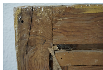
Detalle del ensamble del bastidor y marco.
