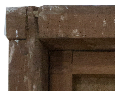
Detalle del ensamble del bastidor y marco.
