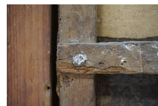
Detalle del ensamble del travesaño.
