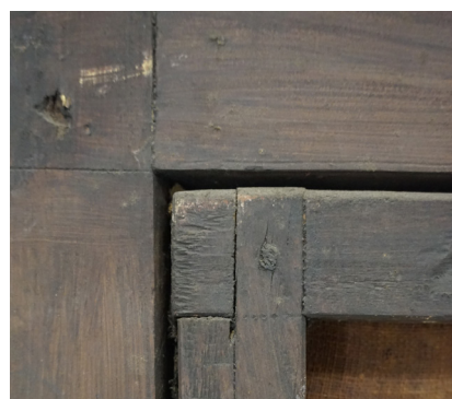
Detalle del ensamble del bastidor y marco.
