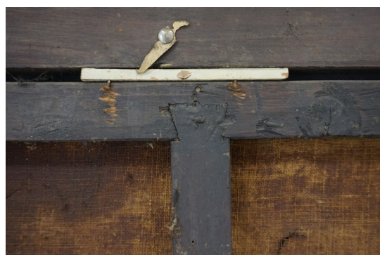
Detalle del ensamble del travesaño.
