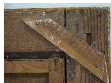
Detalle del ensamble del bastidor y marco.
