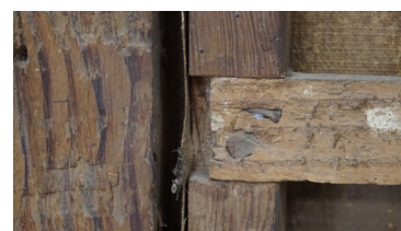
Detalle del ensamble del travesaño.
