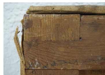
Detalle del ensamble del bastidor.
