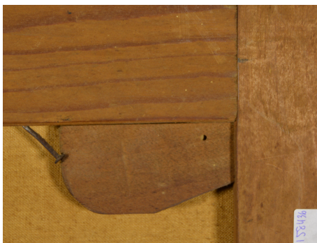
Imagen 23: Detalle del sistema de sujeción de las cuñas.
